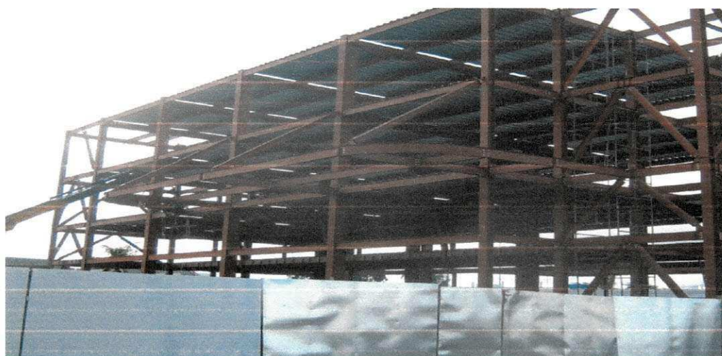
Figura 11 – Estrutura Montada Hotel Ibis
