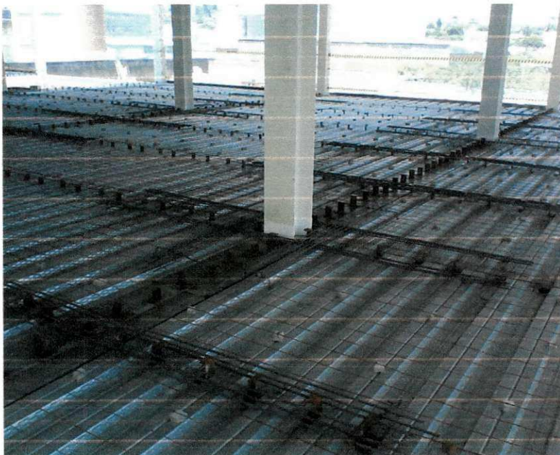
Figura 20 –Lajes steel deck com conectores e ferragem negativa da Faculdade Maurício de Nassau Campina Grande_PB Fonte: Gregório Lobão
