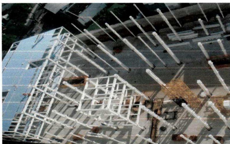
Figura 14 – Armação de lajes, vigas e pilares e colocação da grua Mauricio Nassau – João Pessoa-PB
