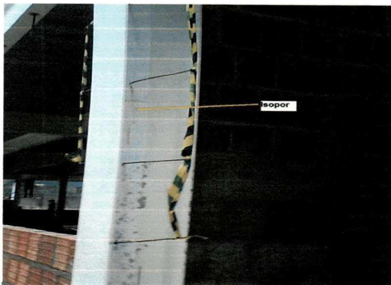
Figura 06: Colocação do isopor FONTE: Gregório Lobão, 2009
