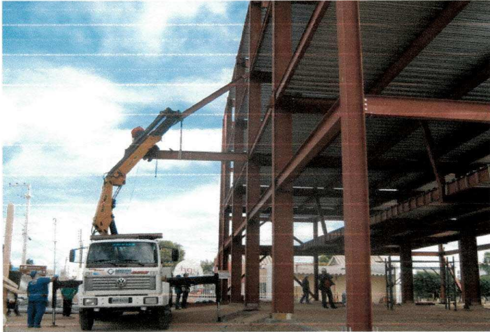
Figura 09 – Colocação de vigas por caminhão Munck do Hotel Ibis
