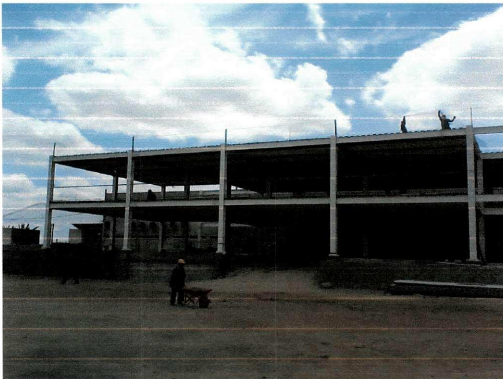
Figura 18 – Parte da estrutura metálicas da Faculdade Maurício de Nassau Campina Grande-PB
