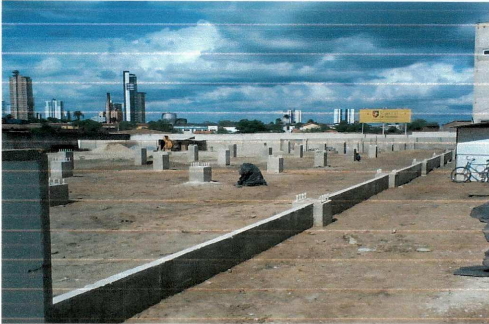
Figura 17 – Fundação feita pela BMC com os chumbadores Faculdade Maurício de Nassau Campina Grande-PB
