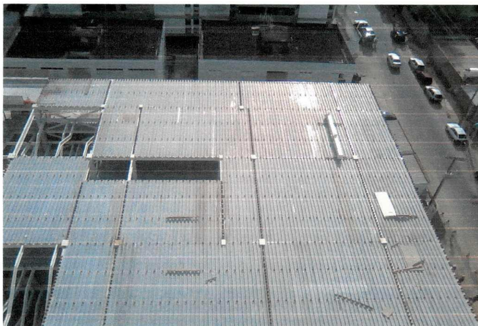
Figura 07: Laje Steel Deck FONTE: Ranieri Pinto, 2009
