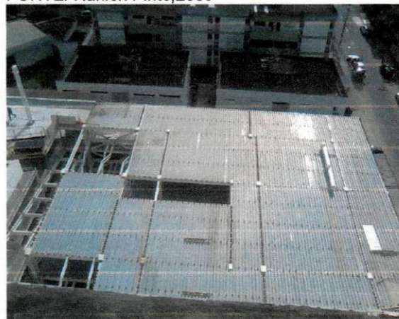
Figura 04: Lajes Steel Deck FONTE: Ranieri Pinto,2009
