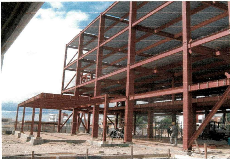
Figura 10 – Estrutura Montada Hotel Ibis
