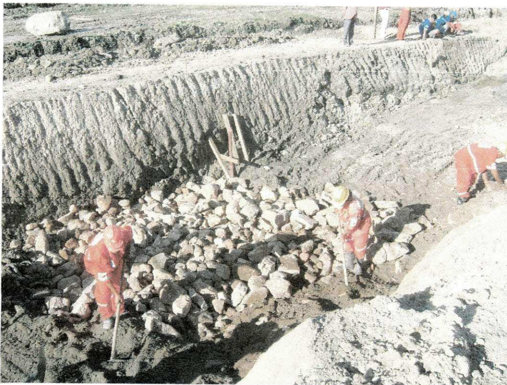
FIGURA 14: Estabilização do fundo do canal (fonte: Arquivo, Andrade Galvão).
