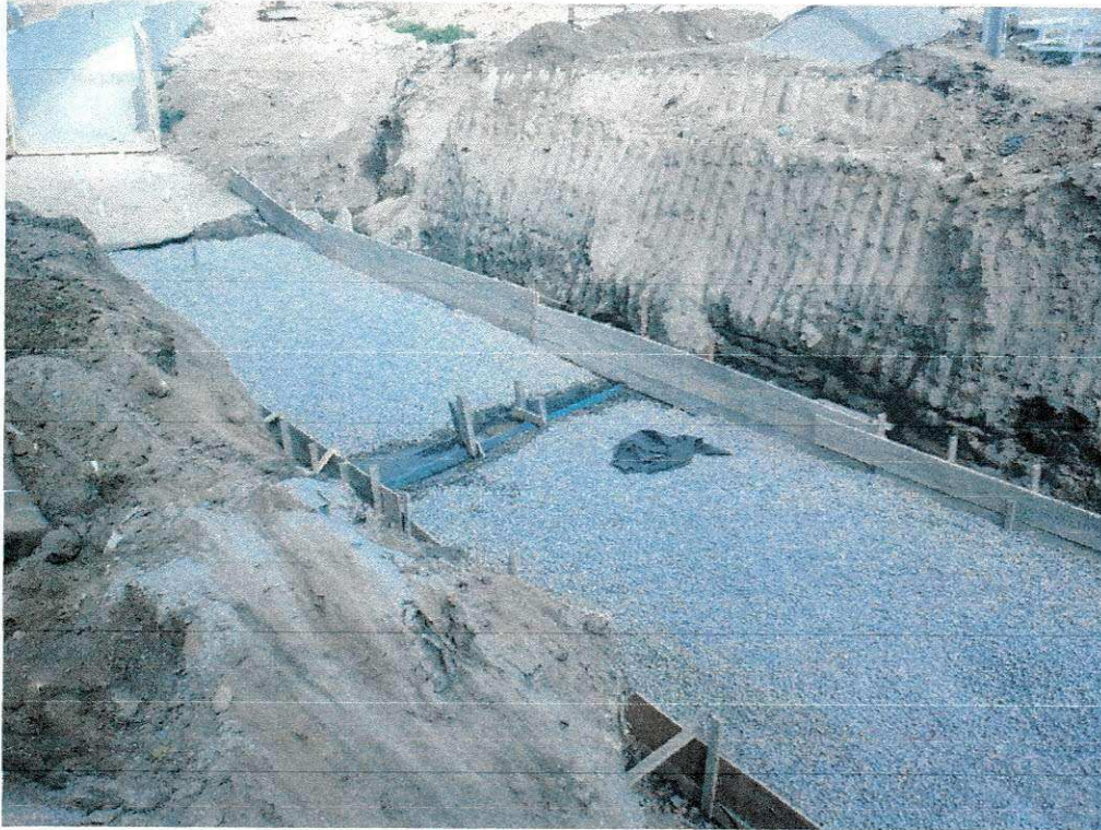
FIGURA 16: Colocação da camada de brita (fonte: Arquivo, Andrade Galvão).
