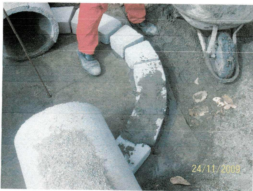
FIGURA 10: Encontro dos tubos com o PV (fonte: Arquivo, Andrade Galvão).
