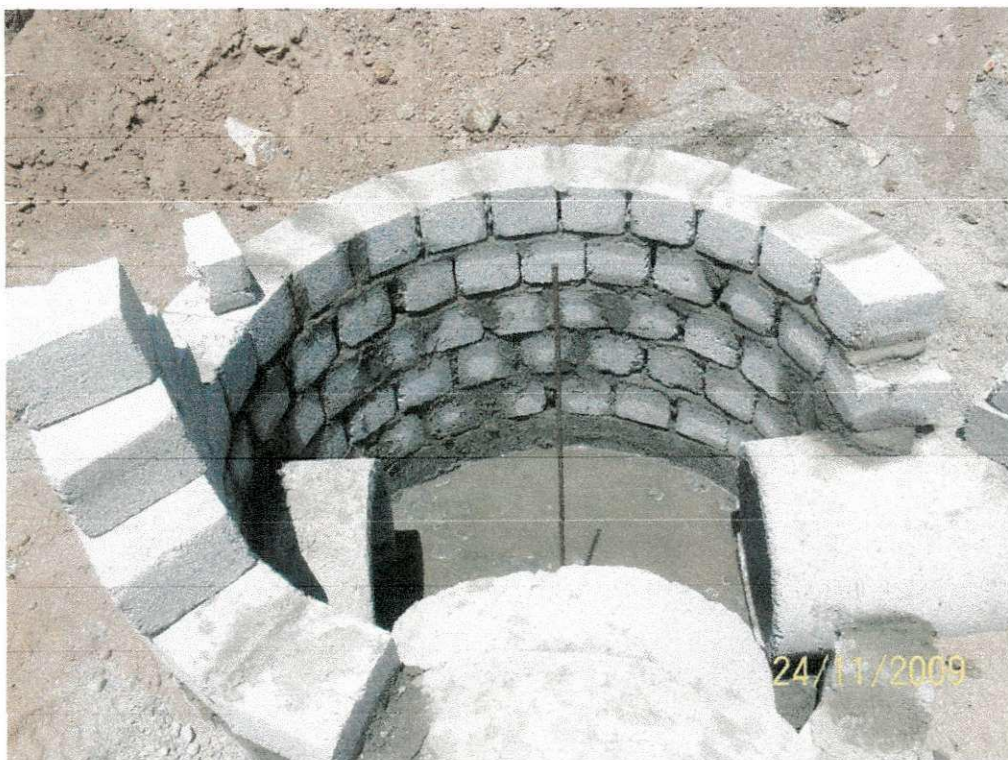
FIGURA 11: Construção do PV (fonte: Arquivo, Andrade Galvão).
