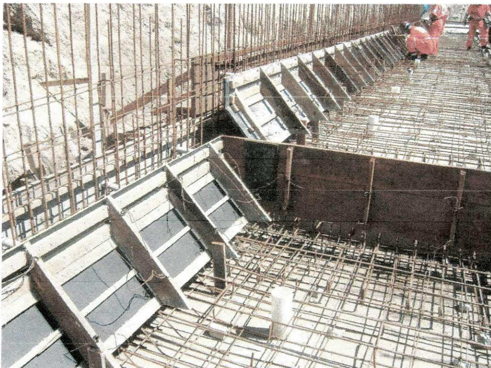
FIGURA 19: Formas para concreto estrutural, 2ª etapa (fonte: Arquivo, Andrade Galvão).
