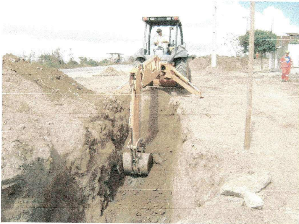
FIGURA 7: Escavação de vala (fonte: Arquivo, Andrade Galvão).
