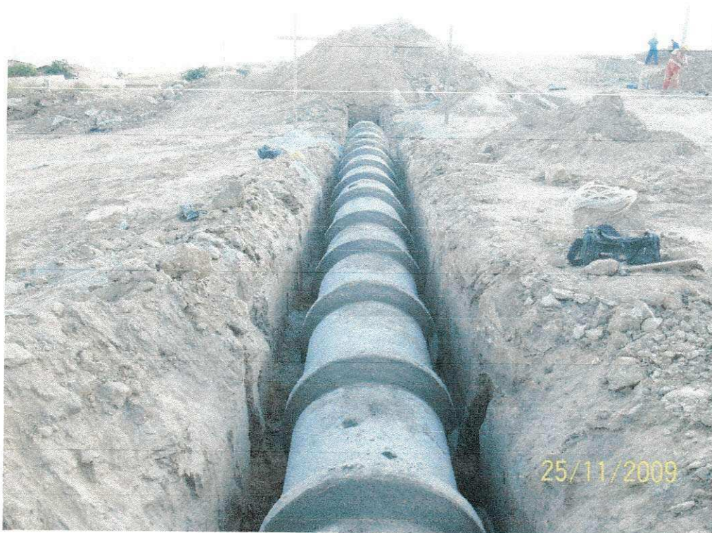
FIGURA 9: Assentamento concluído (fonte: Arquivo, Andrade Galvão).
