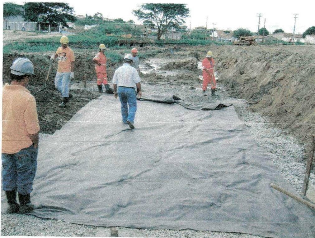
FIGURA 15: Colocação da manta geotêtil (fonte: Arquivo, Andrade Galvão).
