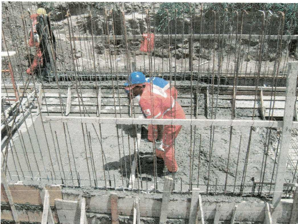
FIGURA 20: Lançamento do concreto estrutural no fundo do canal (fonte: Arquivo, Andrade Galvão).
