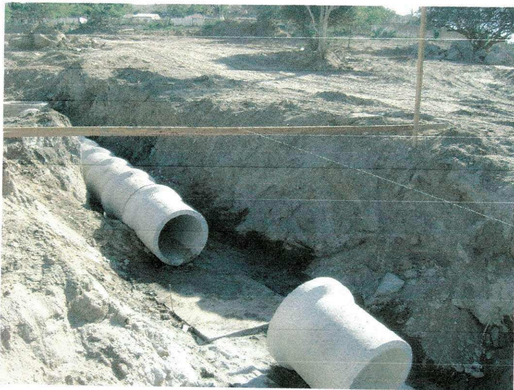
FIGURA 8: Assentamento de tubos (fonte: Arquivo, Andrade Galvão).
