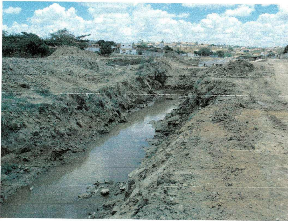
FIGURA 12: Escavação (fonte: Arquivo, Andrade Galvão).
