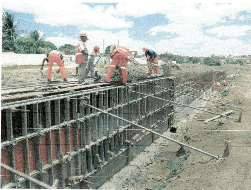
FIGURA 21: Lançamento do concreto estrutural nas paredes (fonte: Arquivo, Andrade Galvão).
