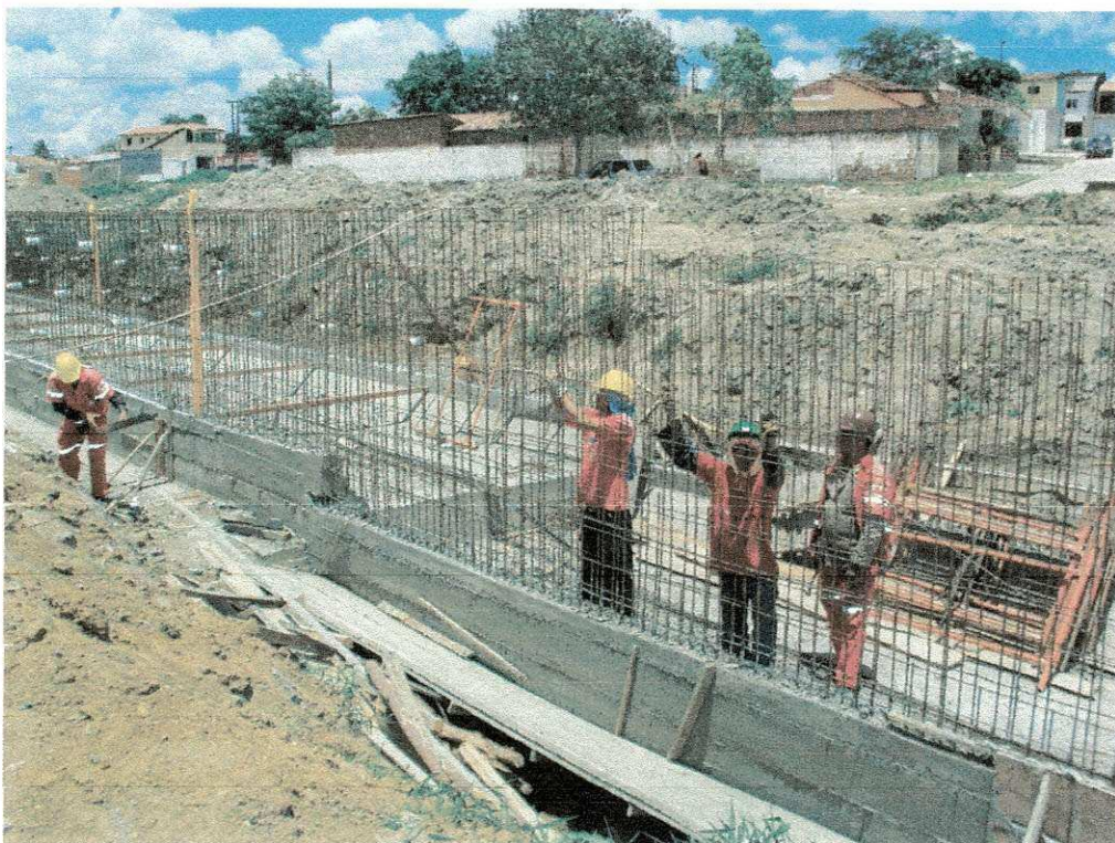
FIGURA 18: Lançamento da armadura (fonte: Arquivo, Andrade Galvão).
