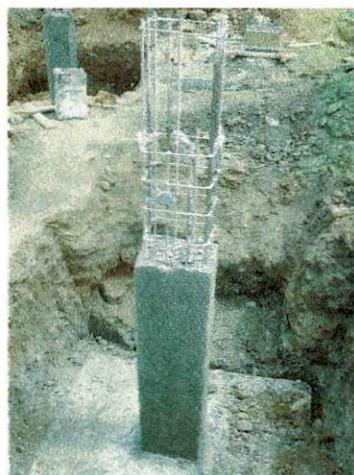
Foto 03 – Pilar concretado
