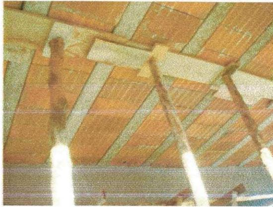
Foto 06 – Escoramentos da laje pré-moldada
