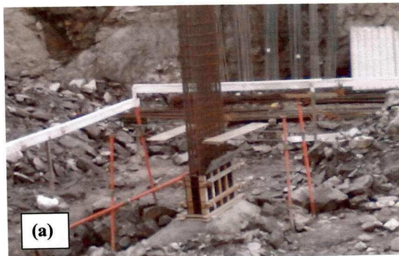
Figura 8. Foto mostrando a execução da fôrma do toco de pilar (a).
