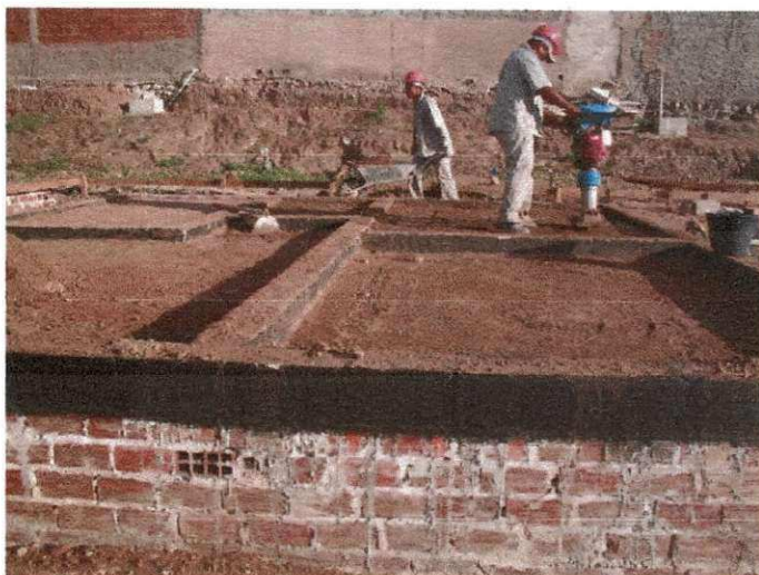
Figura 14 – Compactação do caixão da construção
