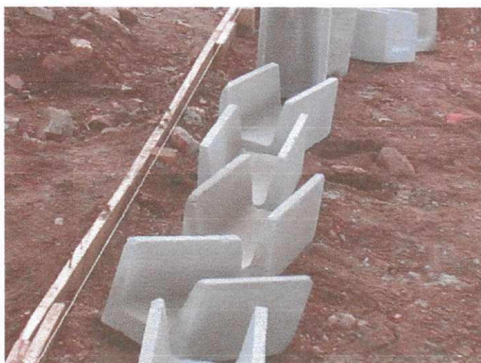
Figura 27 – Canaleta de concreto
