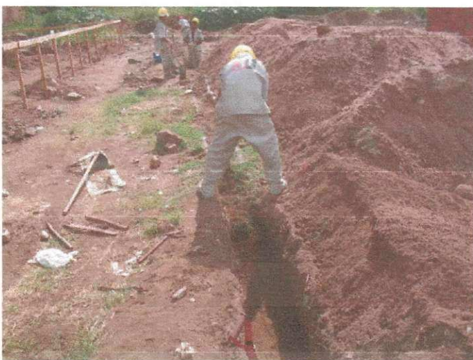
Figura 9 – Escavação de Vala
