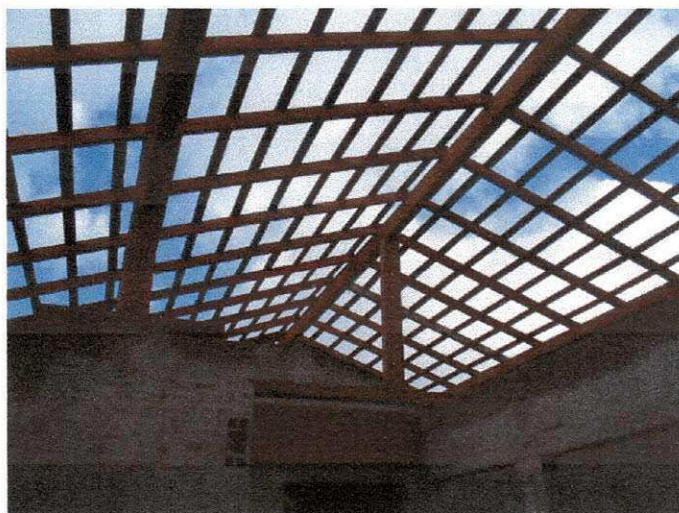
Figura 21 – Madeiramento do telhado
