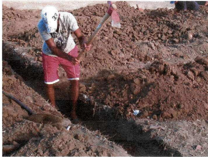
Figura 4 – Escavação da vala
