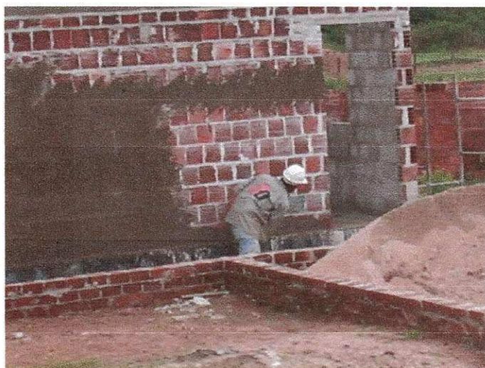
Figura 20 – Execução do Chapisco
