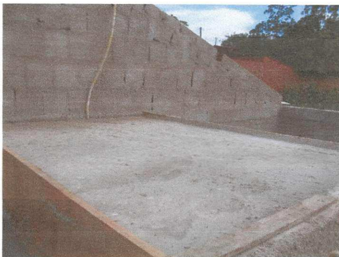
Figura 18 - Laje do banheiro
