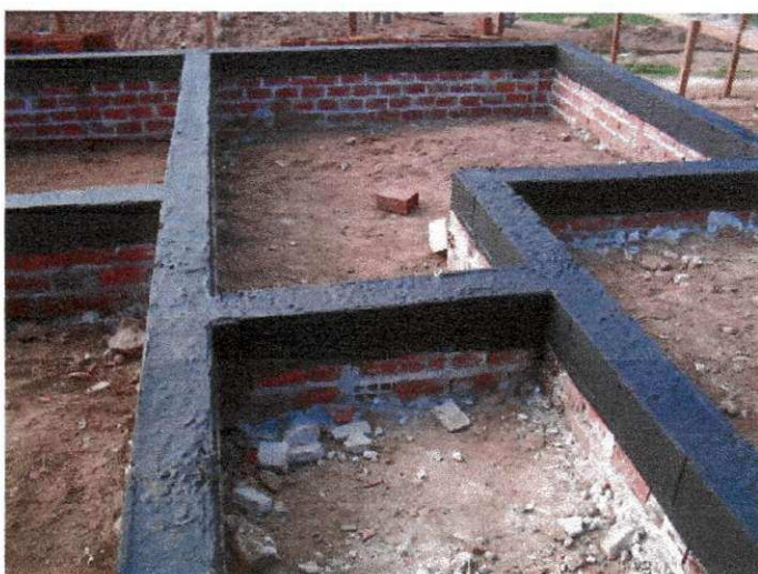
Figura 13 – Cintas inferiores impermeabilizadas
