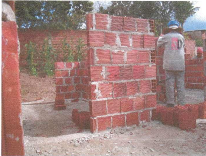
Figura 16 – Alvenaria de meia vez
