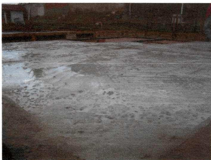
Figura 15 – Lastro de concreto
