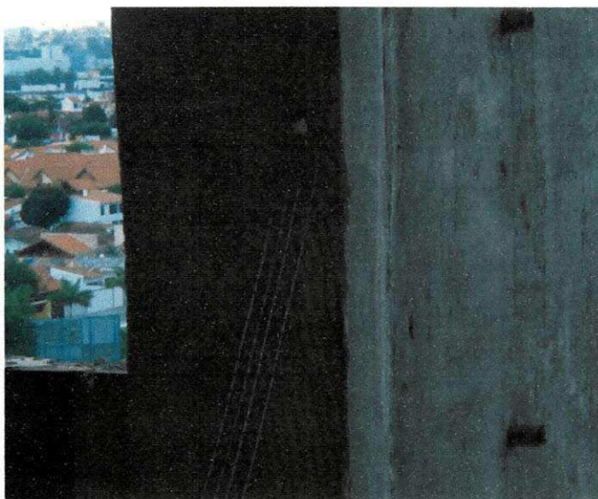
Figura 9 – Reforço metálico: usado para dar mais rigidez às paredes.
