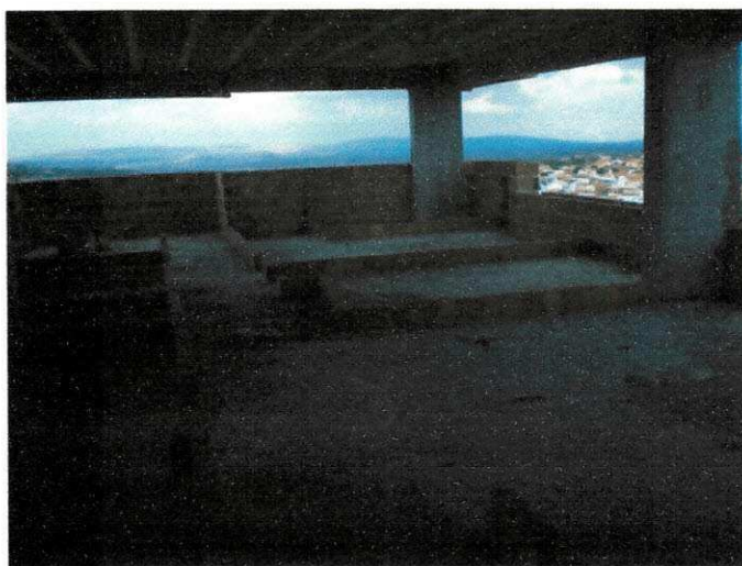
Figura 7 – Alvenaria de marcação e de periferia.
