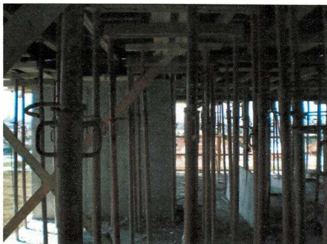
Figura 3 – Espaçamento entre as escoras.
