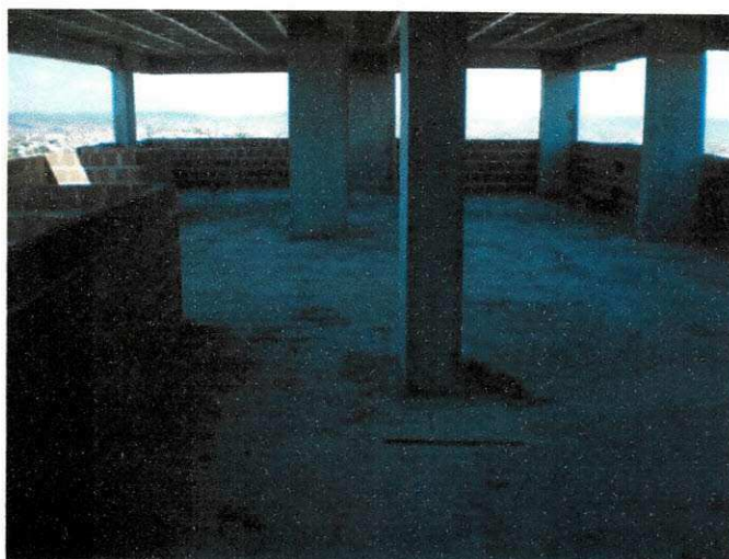
Figura 14: Pavimento após o levantamento da alvenaria de periferia. Detalhe na limpeza.
