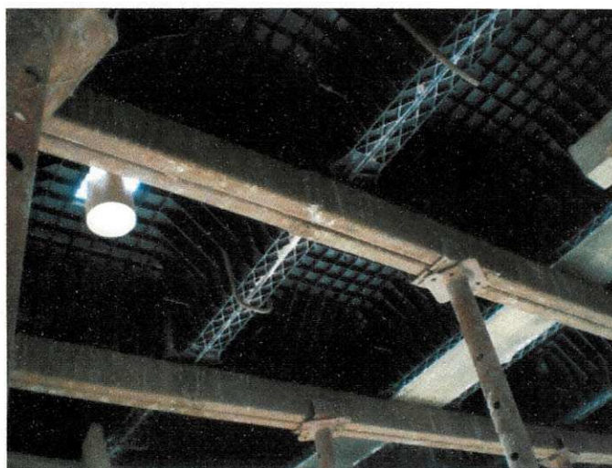
Figura 4 – Escoras para a laje.
