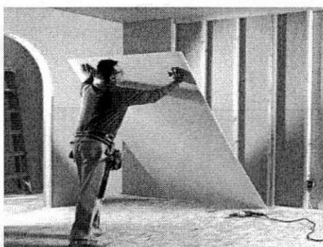
Figura 13- Placas em Drywall
