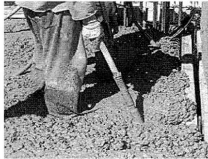
Figura 30- Adensamento do Concreto com Vibrador de Imersão
