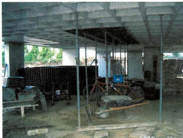
**Figura 59.** Retirada das fôrmas das lajes e vigas.
