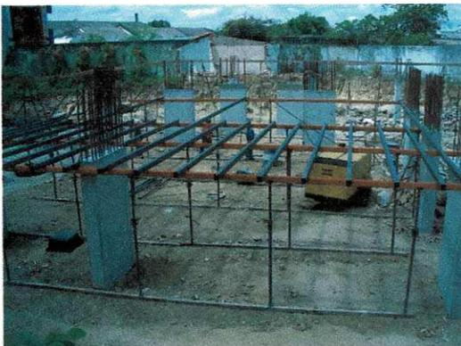
**Figura 46.** Armação das lajes e vigas.
