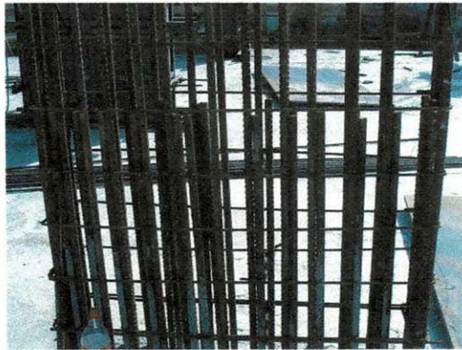
**Figura 37.** Ferragem dos pilares.
