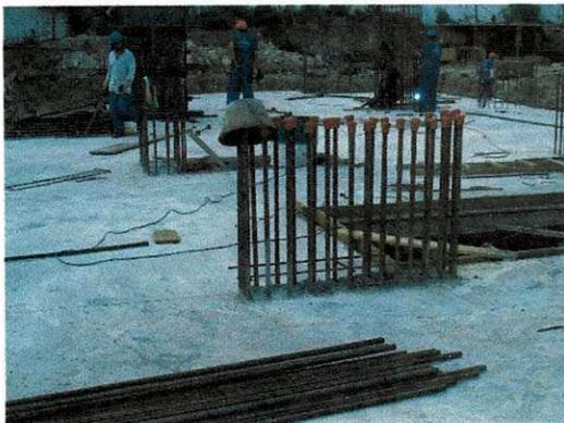
**Figura 36.** Ferragem dos pilares.
