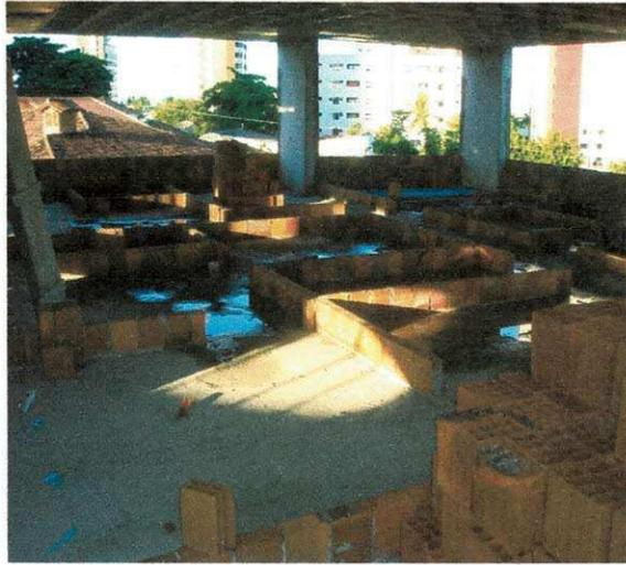
**Figura 79.** Demarcação da alvenaria.
