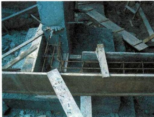
**Figura 49.** Armação das lajes e vigas.
