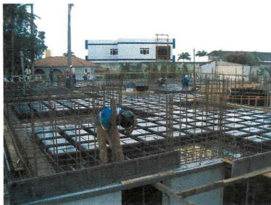
**Figura 50.** Armadura das lajes e vigas.
