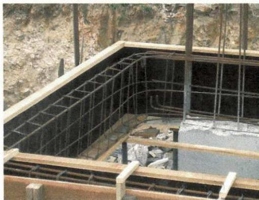
**Figura 52.** Ferragem das lajes e vigas.
