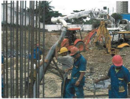
**Figura 31.** Concretagem das sapatas.
