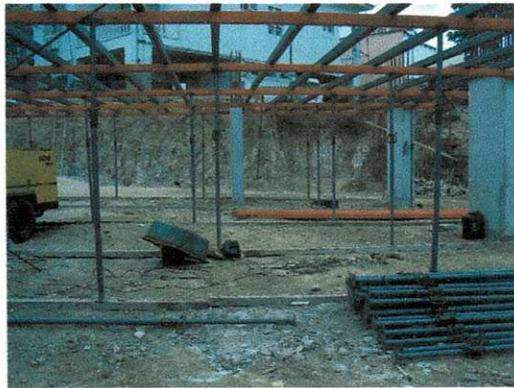
**Figura 47.** Armação das lajes e vigas.
