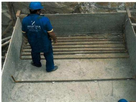
**Figura 26.** Ferragem das sapatas.
