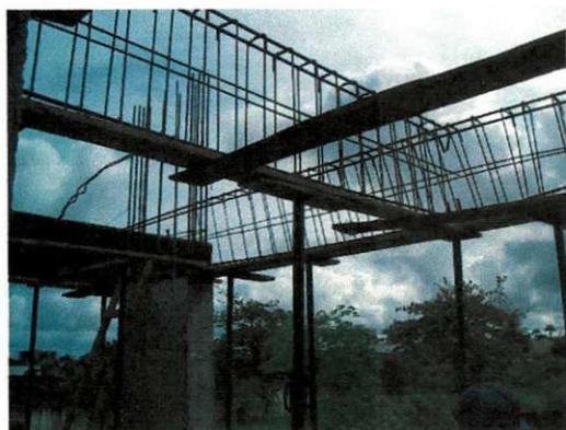
**Figura 51.** Ferragem das lajes e vigas.
