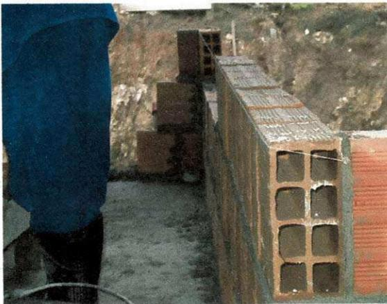
**Figura 70.** Alvenaria de tijolos.
