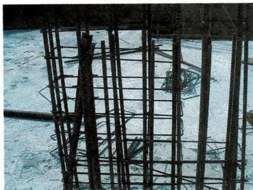
**Figura 38.** Ferragem dos pilares.
