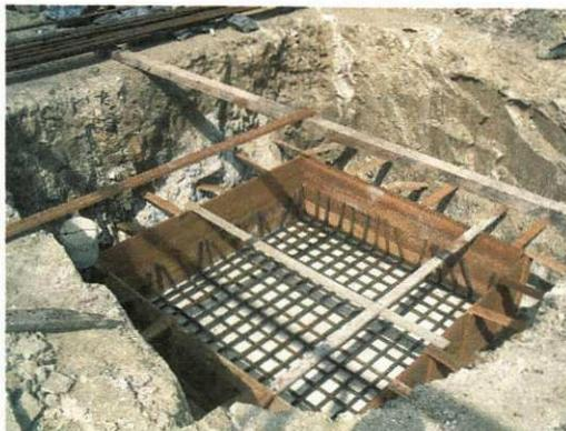
**Figura 27.** Ferragem das sapatas.
