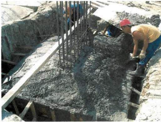
**Figura 32.** Concretagem das sapatas.
