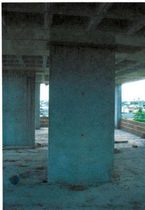
**Figura 45.** Retirada das fôrmas dos pilares.
