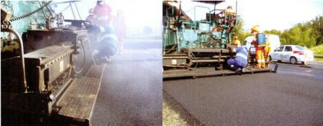
Figura 2 - Comparação visual da emissão de fumos de asfalto gerados na mistura à quente e na mistura morna. SINICESP, 2013.
