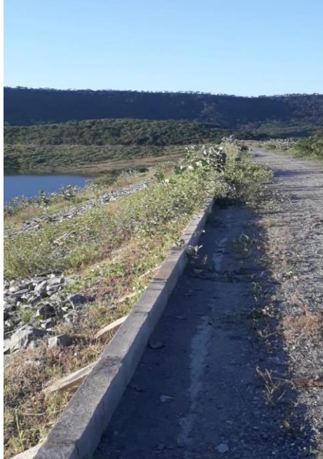
Figura 11: Vista do talude de montante.
