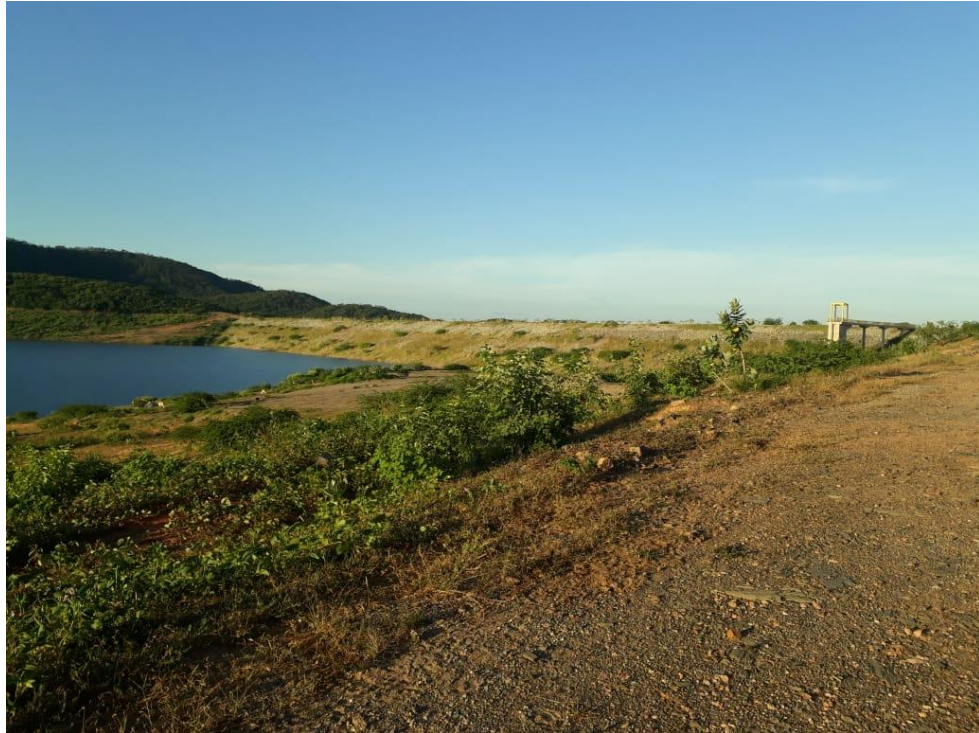
Figura 2: Vista do corpo da barragem de Boa Vista
