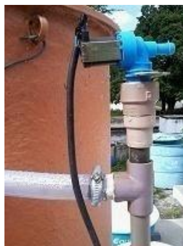
Figura 4.7 – Válvula para entrada de ar na tubulação de descarte
