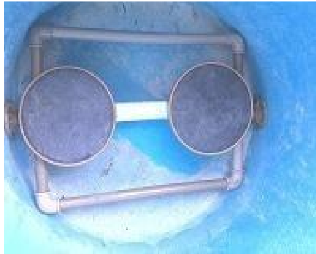
Figura 4.5 – Sistema de ar difuso por membrana
