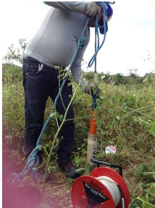
Figura 19 – Remoção da caçamba cilíndrica no interior do piezômetro.
