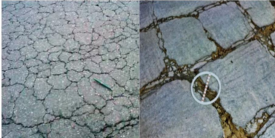
FIGURA 4 – COURO DE JACARÉ VERSUS TRINCAS DE BLOCO.
