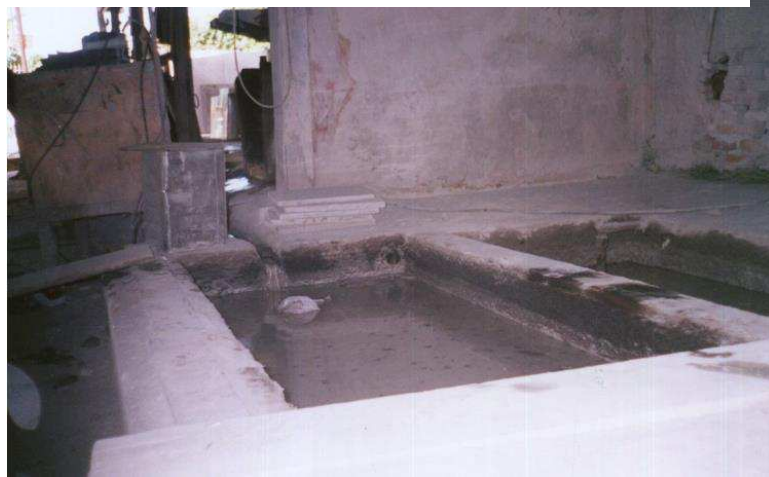
Figura 6 - Tanques de decantação
