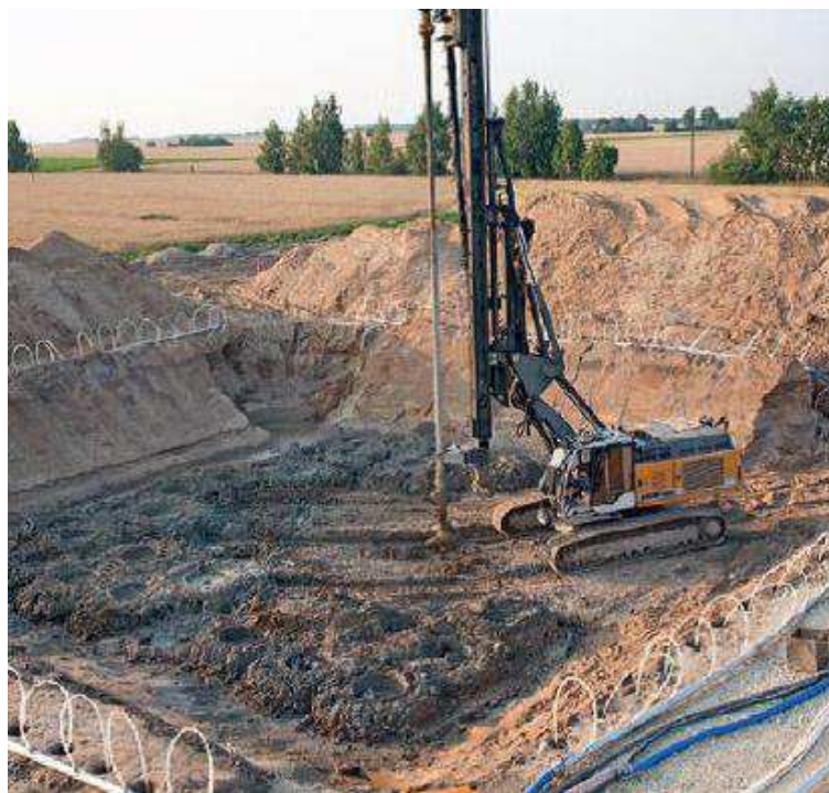
Figura 11 - Execução de um aterro com técnica DSM.
