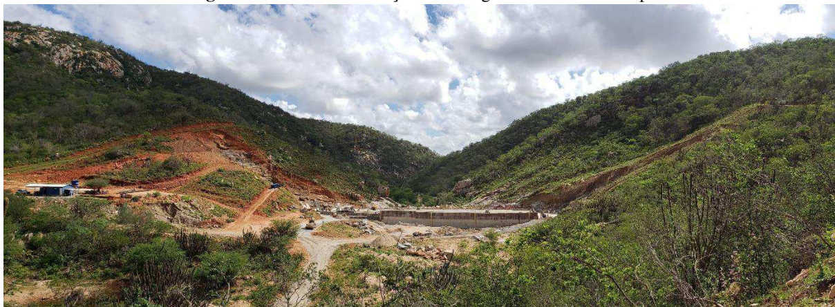
Figura 3: Início da construção da barragem no vale do rio Japí
