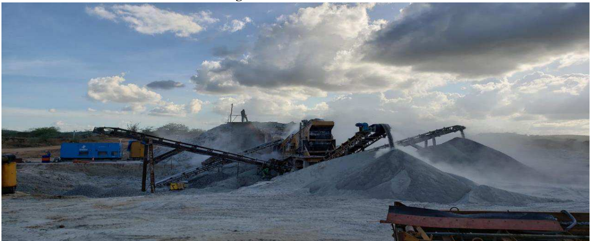
Figura 6: Britador da Obra
