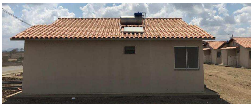
Figura 1: Instalação de boiler no Complexo Habitacional Aluízio Campos.
