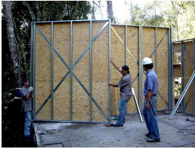
Figura 3: Painéis estruturais em Light Steel Framing
