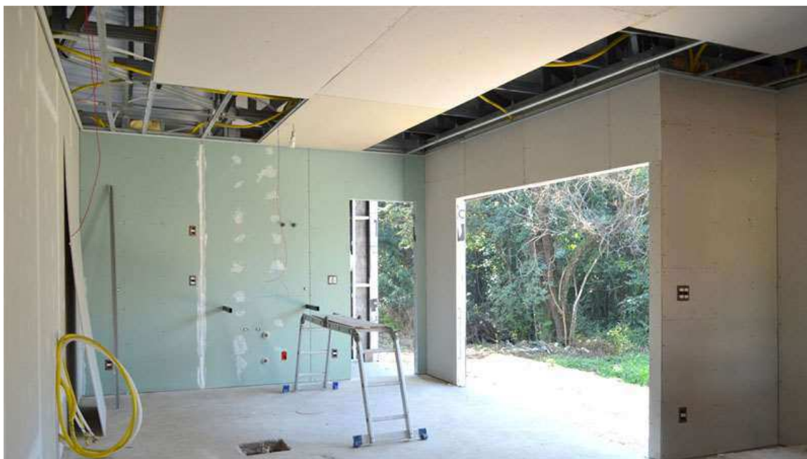
Figura 9: Revestimento interno feito em Drywall
