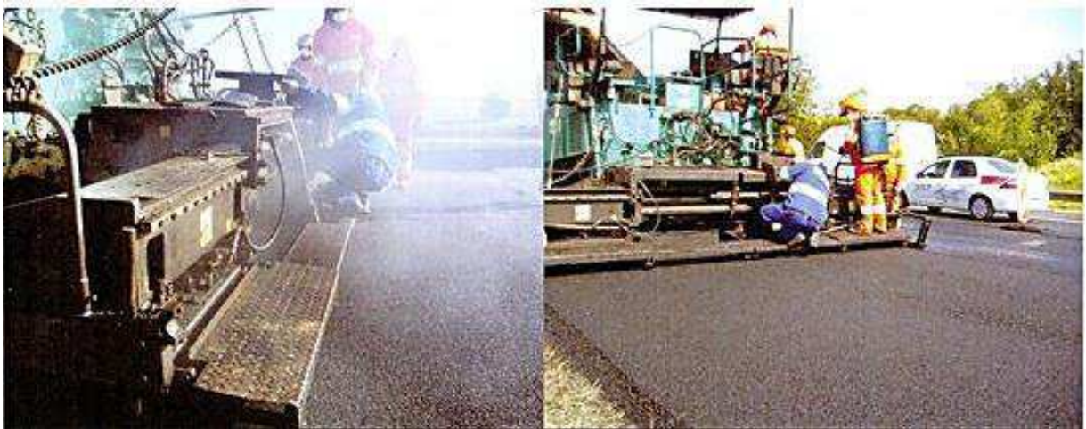
Figura 2 - Diferença durante a aplicação de Misturas a quente e Misturas Mornas
