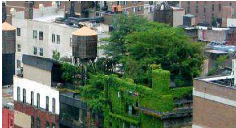
Figura 14- Telhado Verde aplicado em um edifício de Manhattan, Estados Unidos
