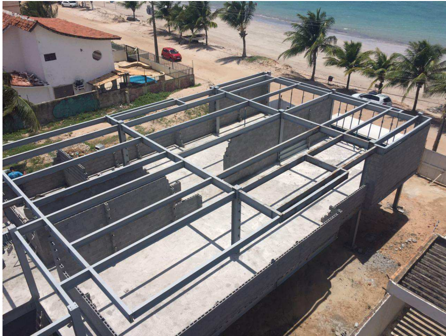
Figura 13 - Vista superior da 2ª laje da estrutura espacial
