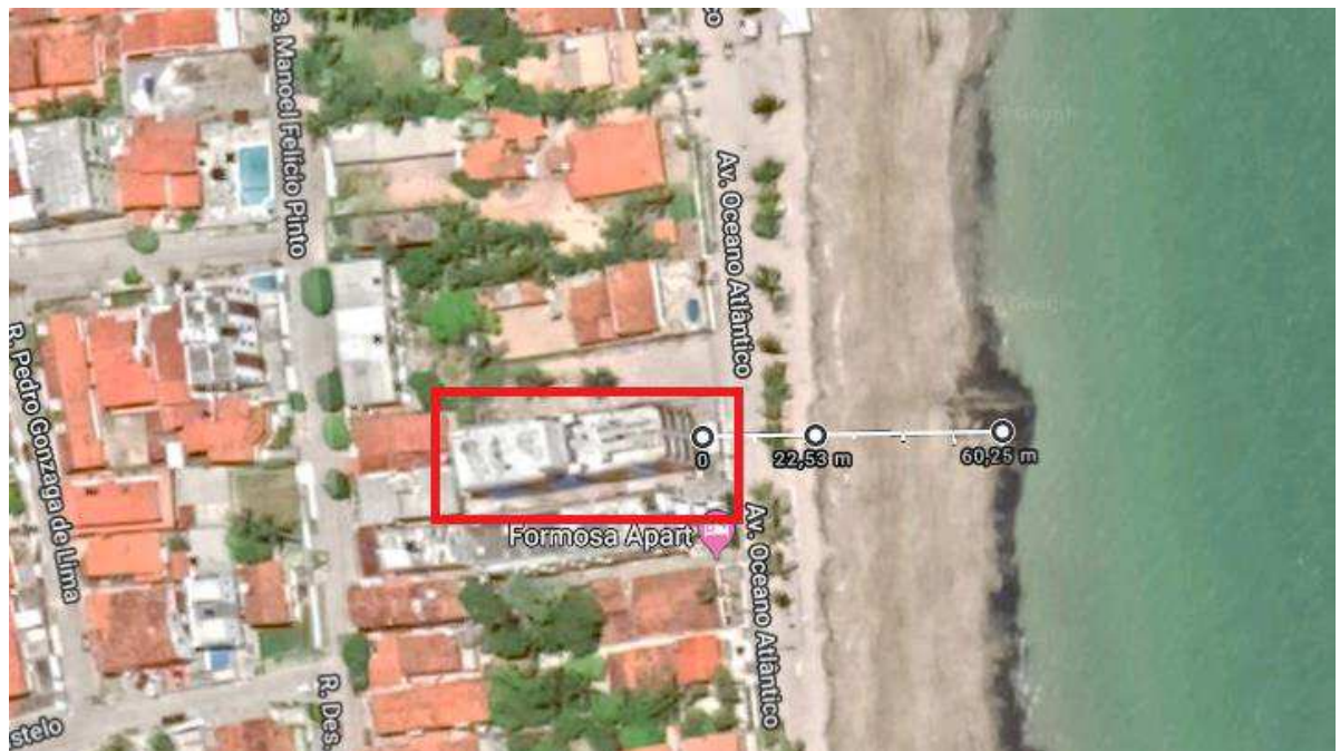
Figura 11 - Imagem de Satélite da Obra em Estudo
