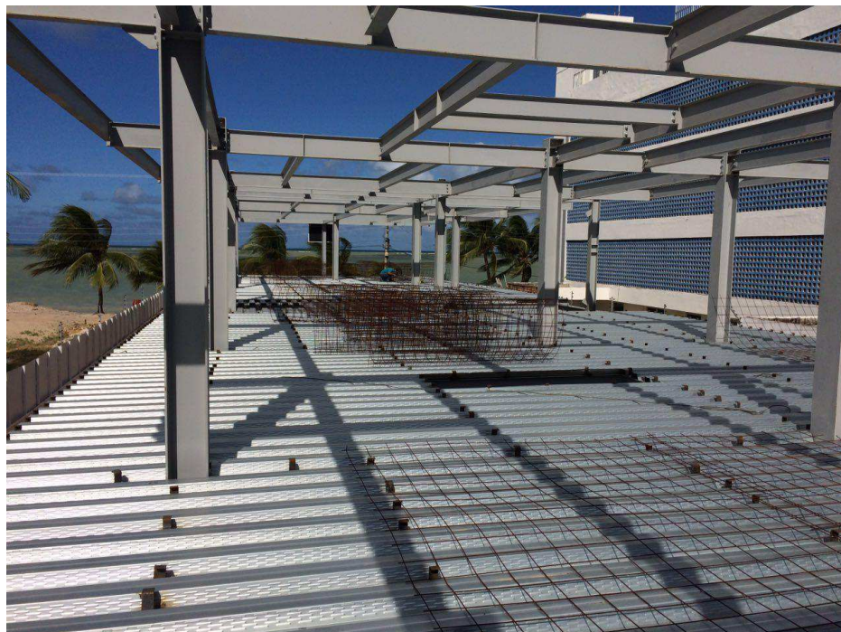
Figura 16 - Montagem de laje steel deck
