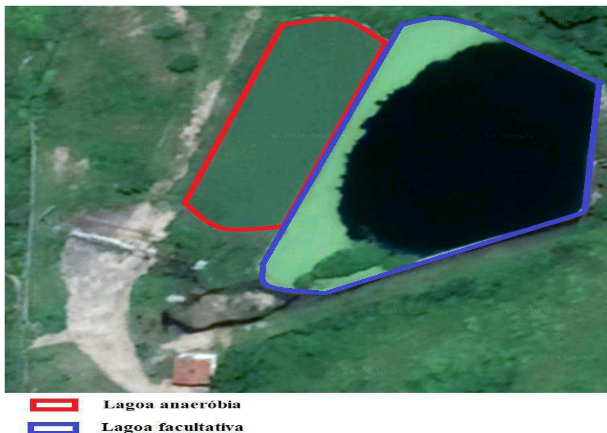
Figura 6 – Estação de Tratamento de Esgoto do bairro Glória
