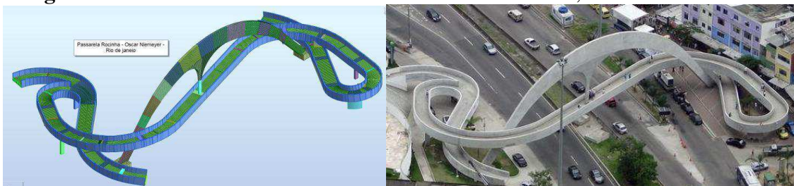
Figura 4: Modelo estrutural e obra finalizada da Passarela Rocinha, Rio de Janeiro - RJ
