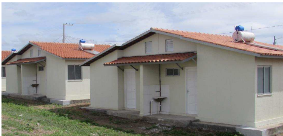
Figura 20. Disposição de boilers e placas solares nas residências do Complexo Aluísio Campos.
