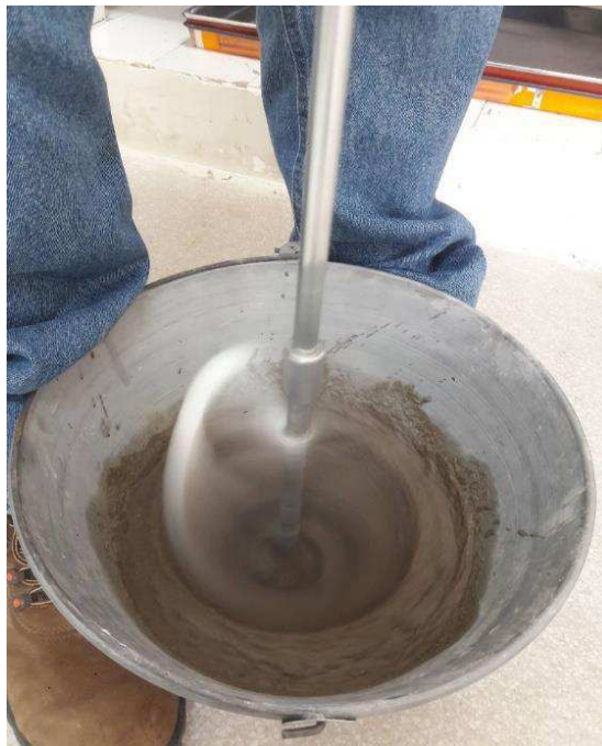
Figura 13 - Mistura da argamassa estabilizada com o misturador.
