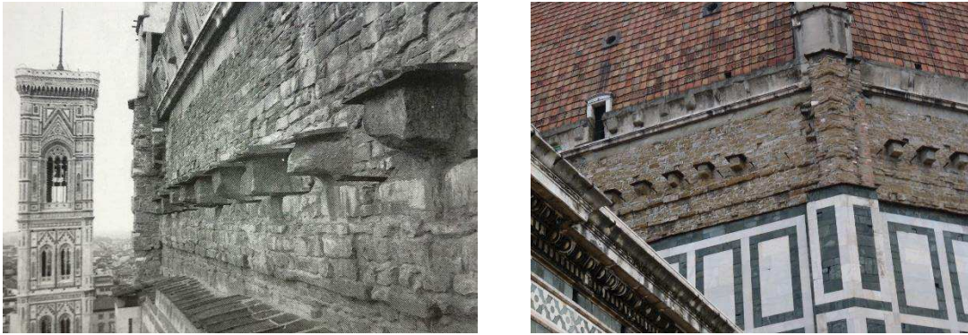
Figura 60: Setor de base da Cúpula (setor sul) com vista das vigas de arenito do primeiro camminamento .
