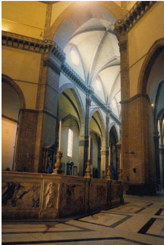
Figura 64: Vista interna de parte do tamburo.
