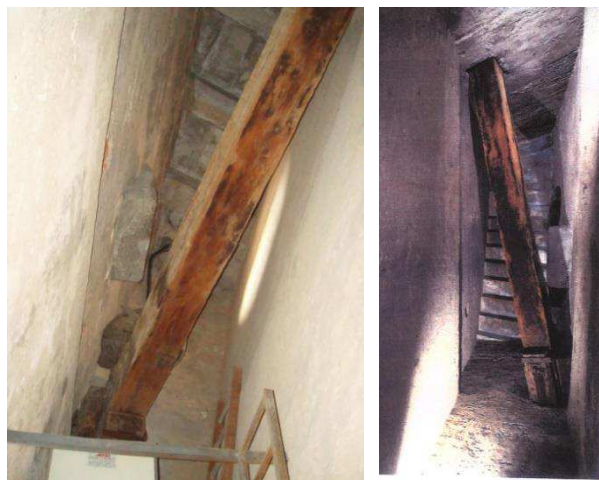
Figura 46: Vista de duas seções da cadeia de madeira passando entre as cúpulas.
