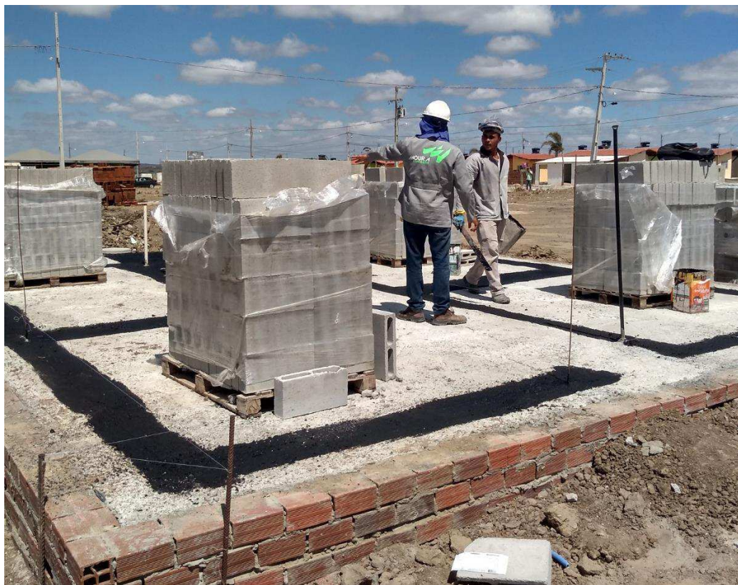
Figura 17- Posicionamento dos blocos de concreto no radier
