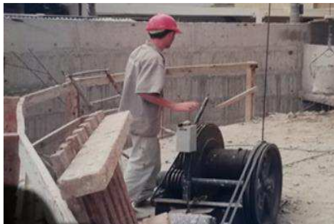
Figura 8 - Operário trabalhando próximo a tambor de enrolar cabo de aço
