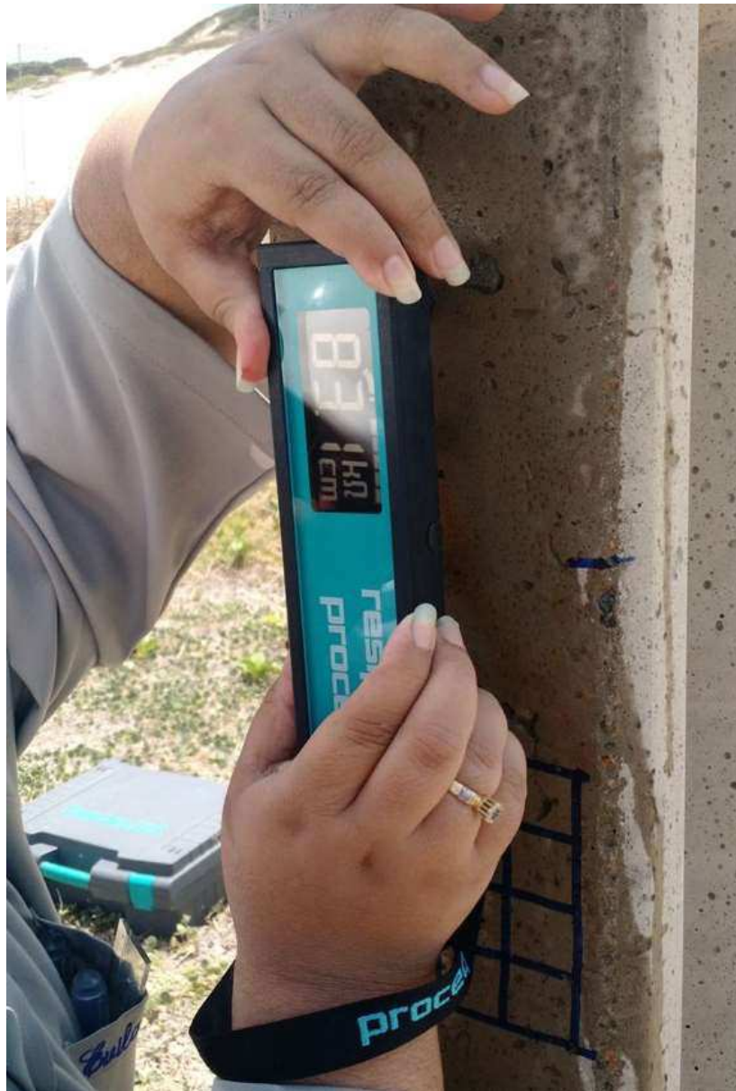
Figura 9-Resipod durante a realização de um dos ensaios de resistividade elétrica.
