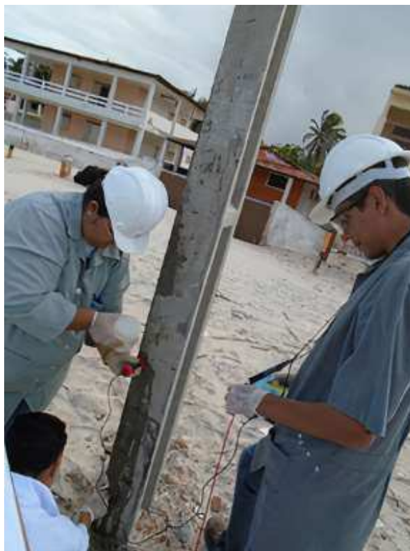
Figura 5-Potencial de corrosão sendo feito em campo.
