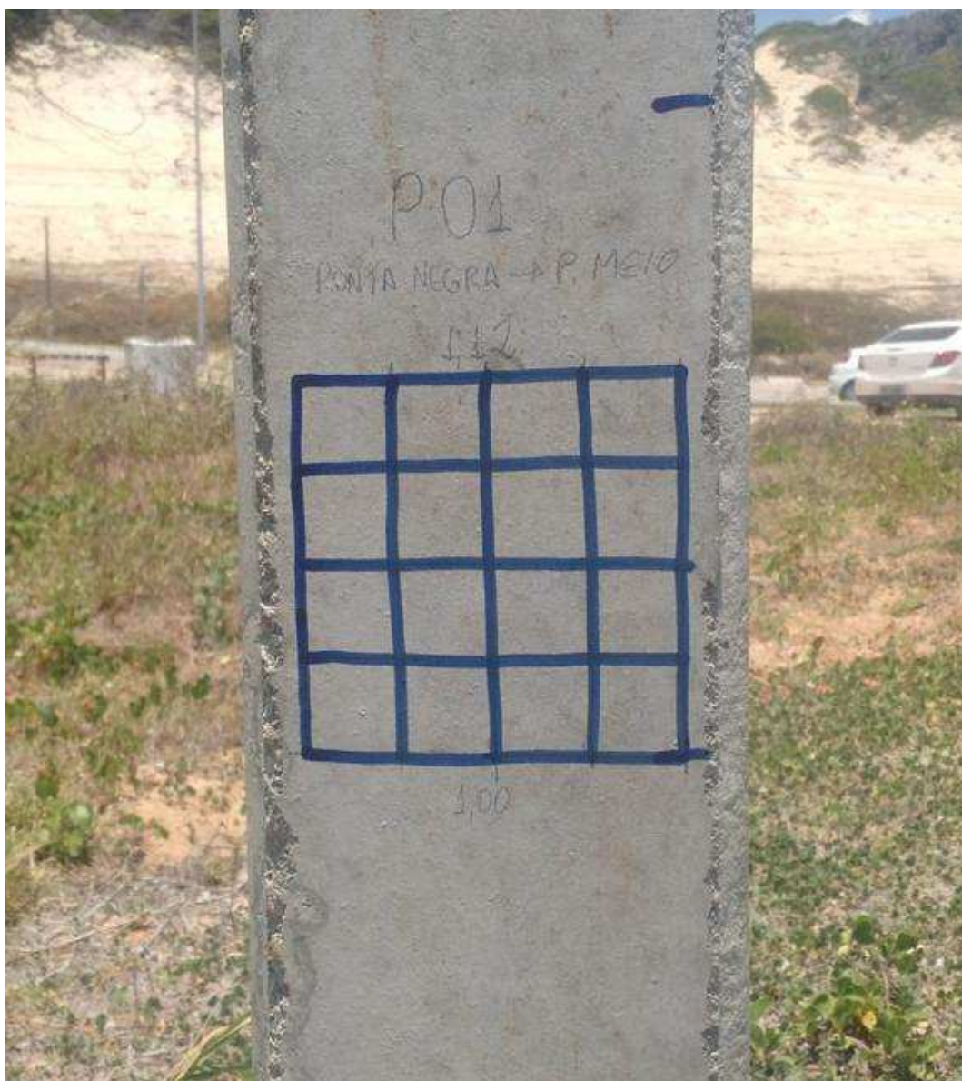
Figura 11-Mapeamento para esclerometria no poste 01
