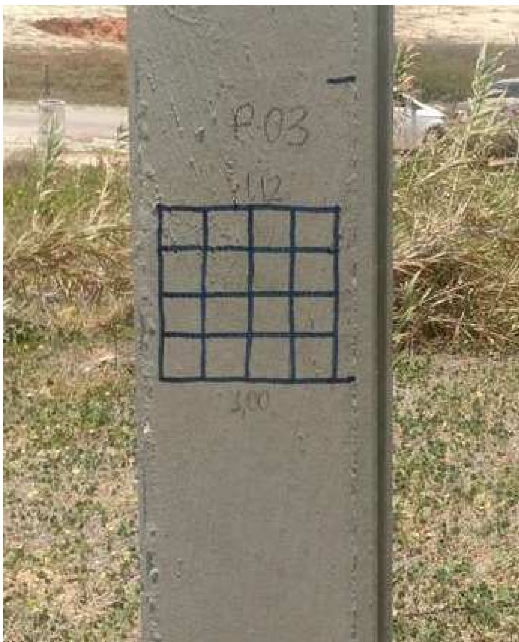
Figura 13-Mapeamento para esclerometria no poste 03.
