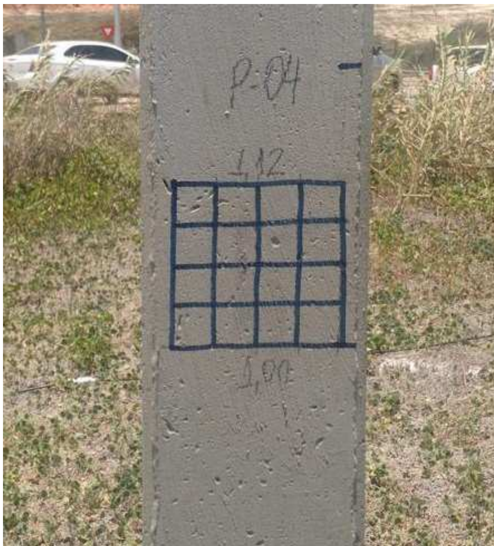
Figura 14-Mapeamento para esclerometria no poste 04.
