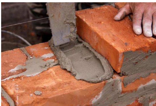
Figura 1: Argamassa de assentamento de blocos.
