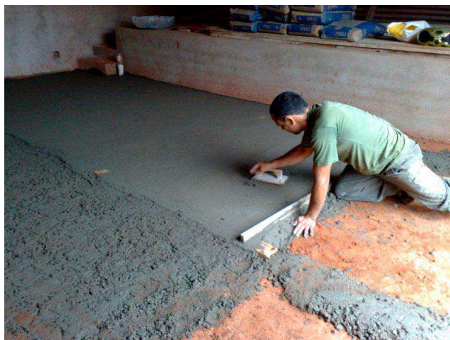
Figura 7: Execução de contrapiso.
