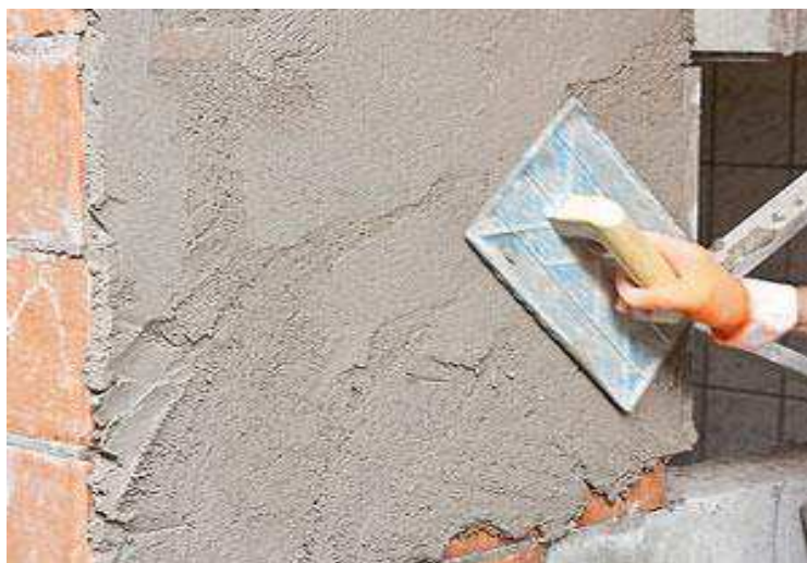
Figura 4: Argamassa de revestimento.
