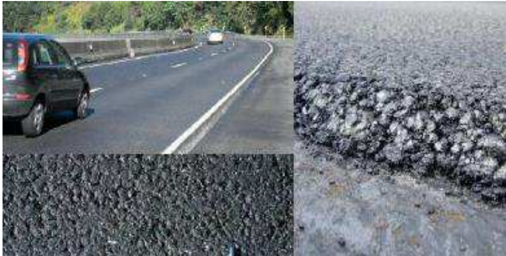
Figura 3: Textura em pista do SMA, BR - 277, Paraná. (EL-HAGE, 2012)
