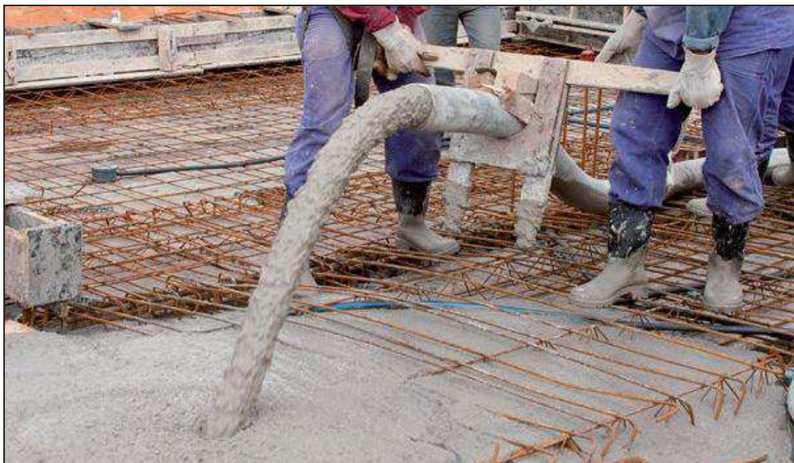
Figura 1 – Concreto sendo empregado no enchimento de laje.
