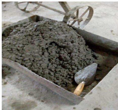
Figura 16 – Massa de concreto.
