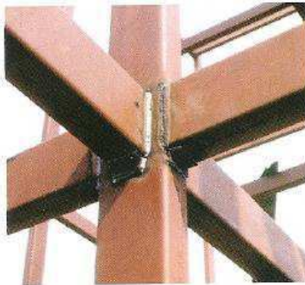
Figura 8 – Conexão soldada rígida da viga na aba do pilar (Adaptado de Luiz Andrade de Matos Dias,2006)
