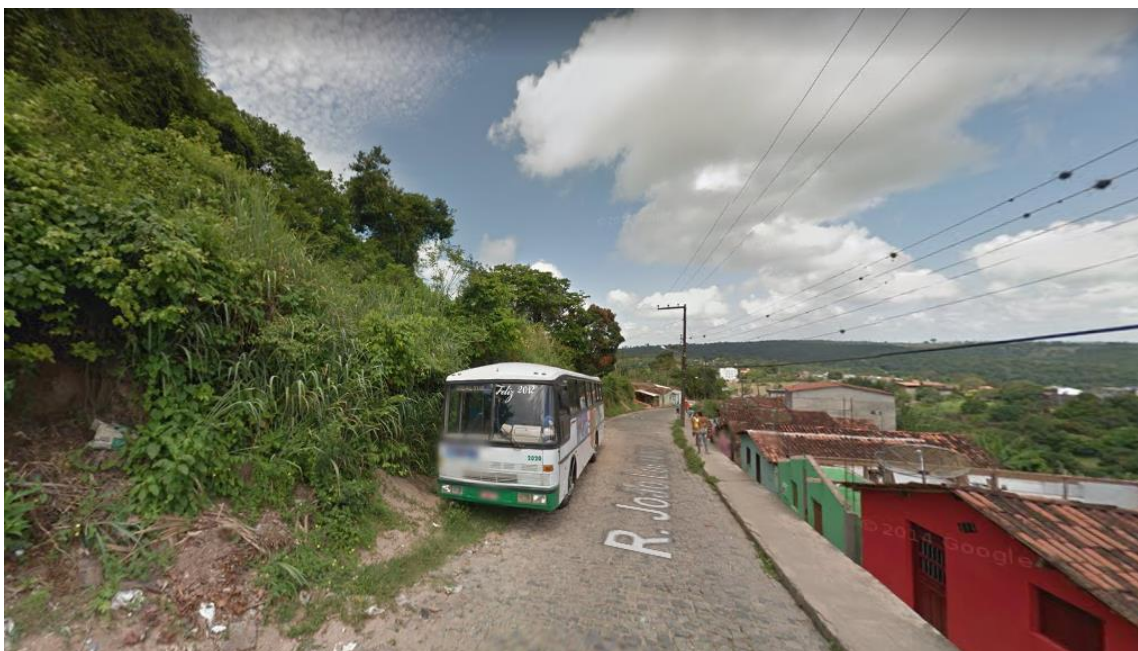
Figura 26: Talude da Rua João Lourenço
