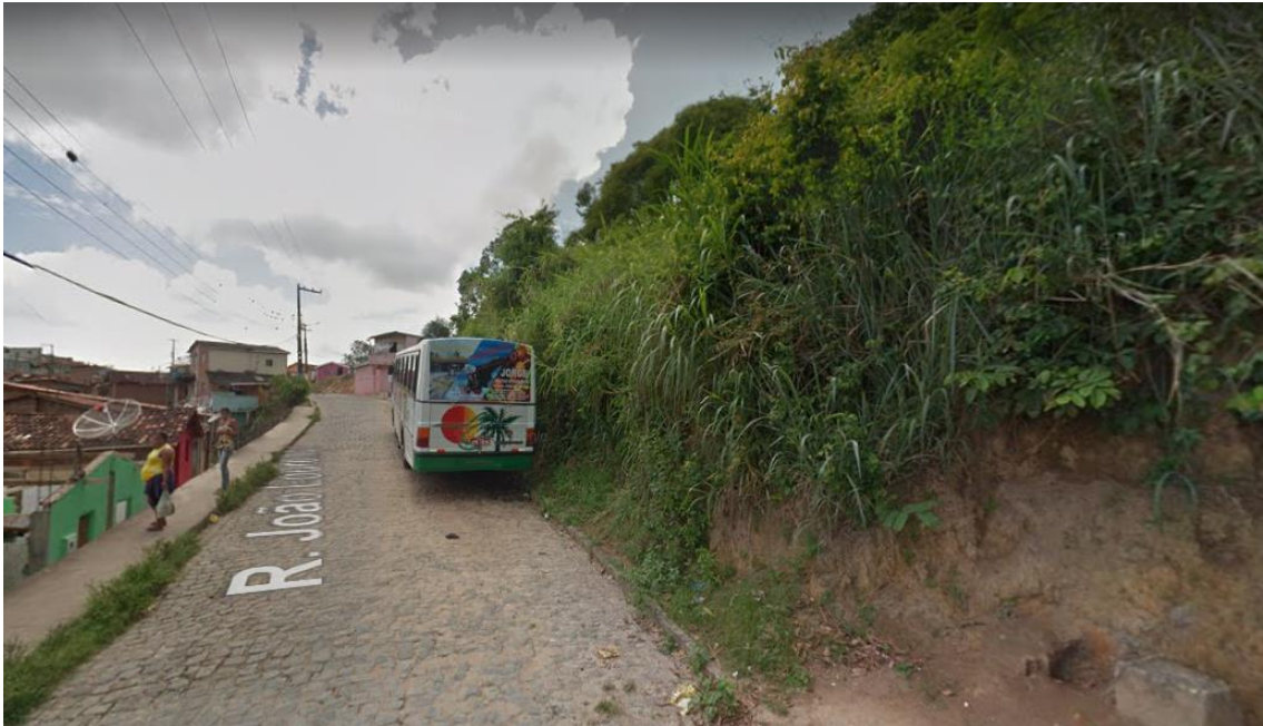
Figura 25: Talude da Rua João Lourenço
