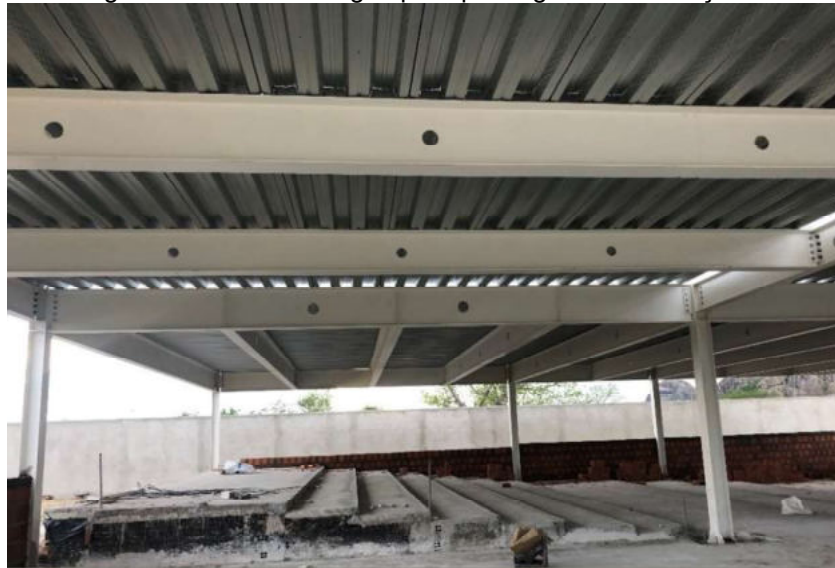
Figura 27 – Furo em vigas para passagem de tubulações.
