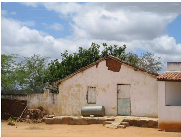
Figura 2-1: Casa-sede da fazenda
