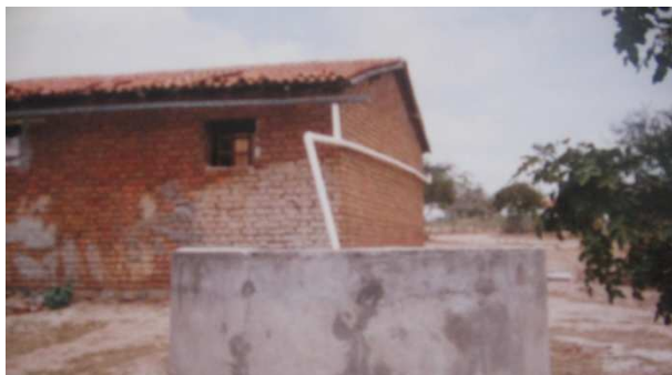
Figura 3-1: Primeira cisterna construída na Paraíba. Salão Comunitário de Caiçara. Fonte: Oliveira (2006).
