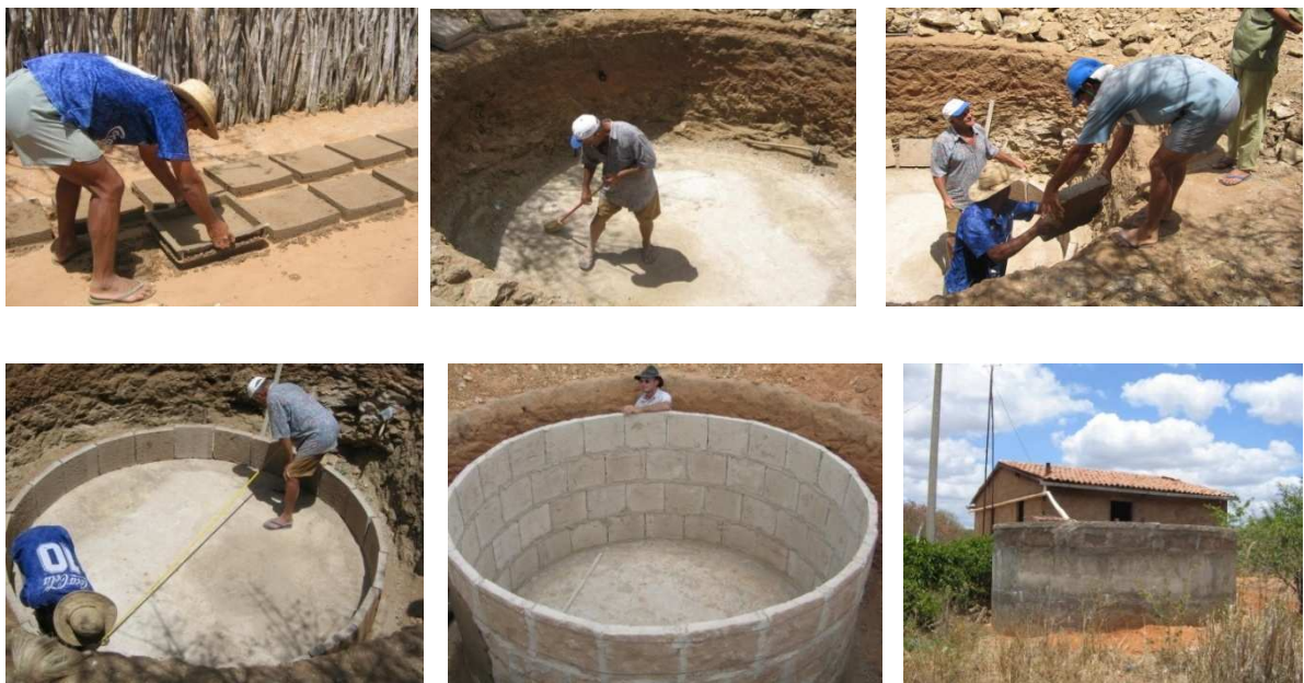
Figura 3-6: Mutirão de construção da cisterna de Mauro, membro do novo grupo de FRS/2005. Fonte: Oliveira (2006).
