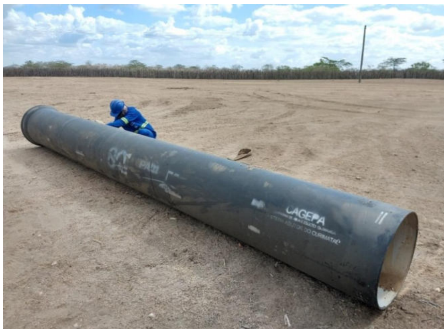
Figura 13 - Tubo de ferro fundido dúctil utilizado na obra (TDK7)
