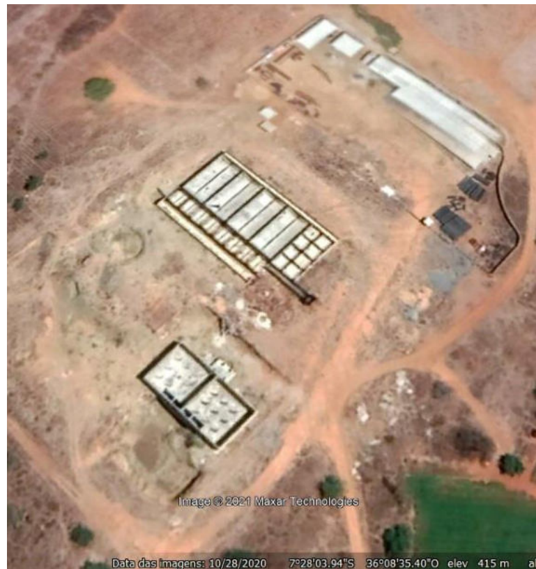
Figura 5 - Vista aérea da futura ETA do Sistema Adutor Transparaíba - Boqueirão - PB
