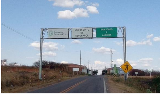
Figura 22- CE 288 que dá acesso a Rodovia Pe. Cícero
