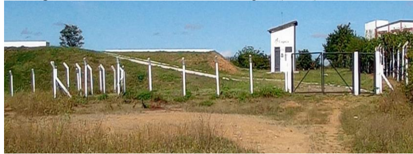
Figura 46- Estação de Tratamento de Esgoto (E.T.E) da CAGECE
