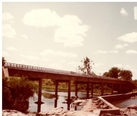
Figura 12- Ponte sobre o Rio Salgado, 1983
