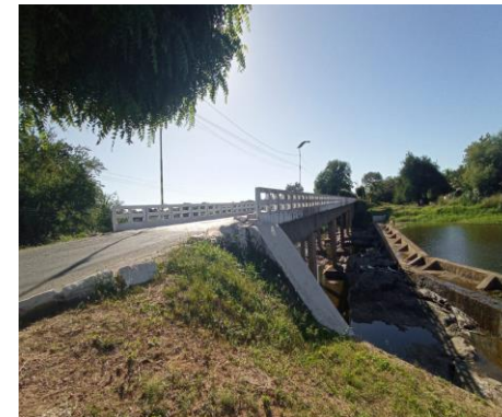
Figura 13- Ponte sobre o Rio Salgado, 2021
