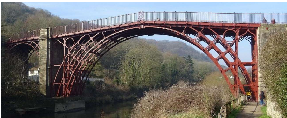
Figura 2 – Ponte Coalbrookdale após uma restauração em fevereiro de 2019. 2
