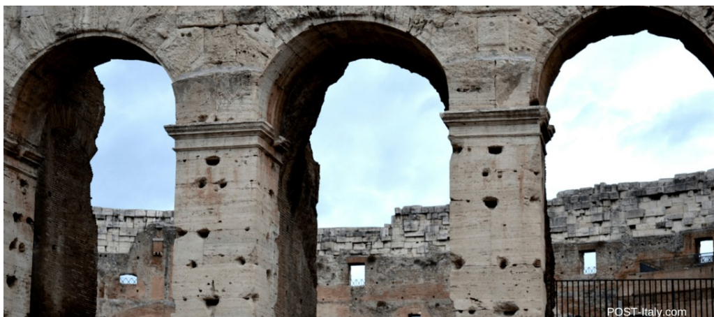
Figura 1 - Pilares do Coliseu após o roubo do cobre de seu interior. 1
