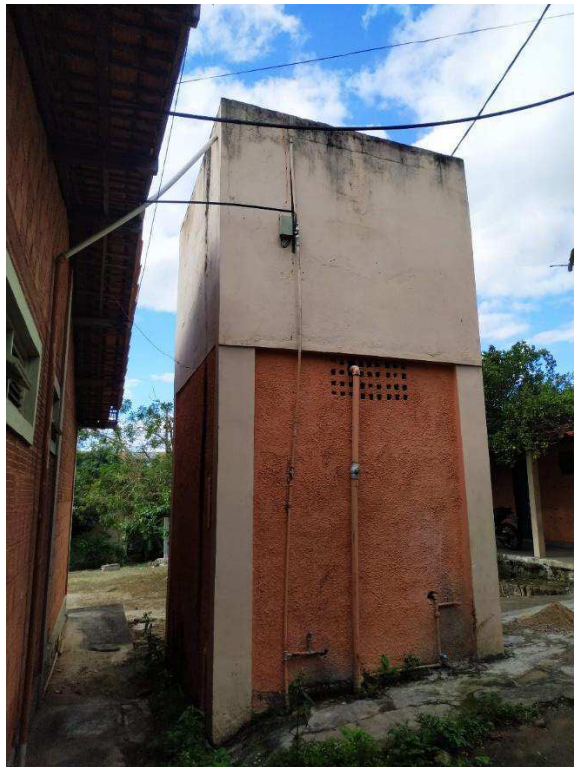
Figura 6 - Reservatório elevado da Prefeitura Universitária – Campus Sede da UFCG
