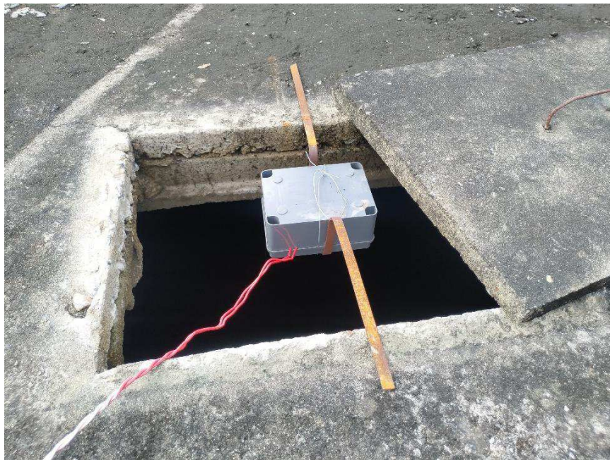
Figura 7 - Instalação do protótipo no reservatório da PU
