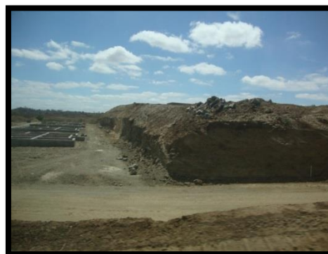
Figura 27 - Uma quadra, duas alturas distintas
