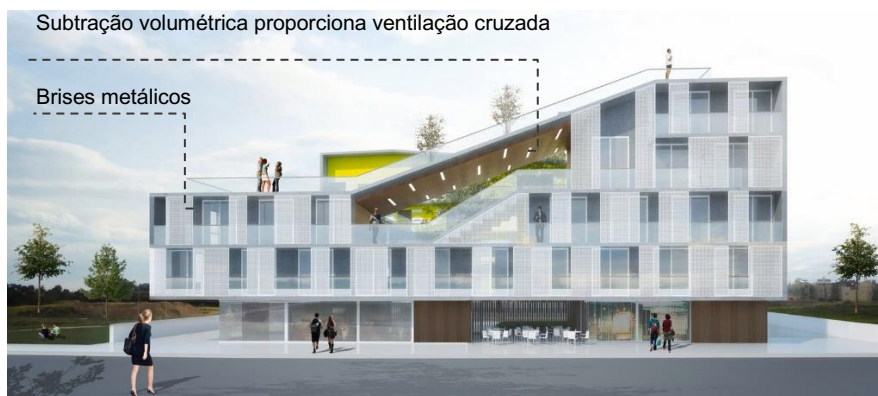
Figura 26 - Fachada frontal do edifício.
