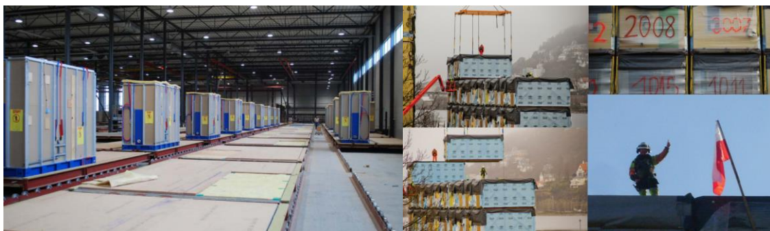
Figura 14 - Processo de fabricação e montagem in-loco dos módulos habitacionais.
