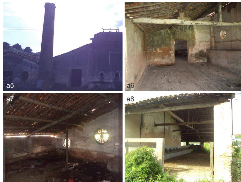
Figura 26 – Casa das caldeiras, casa de purgar e casa de bagaço do Engenho Olho D'água. a5 – ao centro, acesso à casa de purgar; a6 – vista interna da casa de purgar; a7 – vista interna da casa das caldeiras; a8 – vista da casa de bagaço 1.
