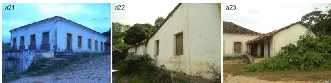
Figura 43 - Construções que compõem a casa-grande. a21 – vista da Construção Original ; a22 – vista dos Acréscimos 1 e 3 ; a23 – vista do Acréscimo 4 . Fonte: Acervo do autor, 2016.
