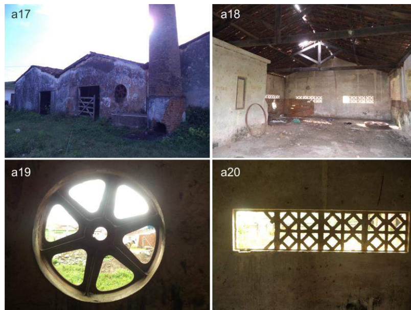
Figura 30 – Acréscimo 2 . a17 – vista da fachada principal; a18 – vista interna do Acréscimo 2 ; a19 – janela circular com gradil de ferro; a20 – elementos vazados.
