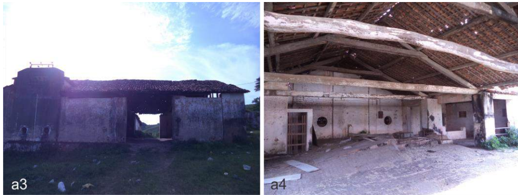
Figura 23 – Casa de moenda do Engenho Olho D’água. a3 – vista da fachada principal da casa de moenda; a4 – vista interna da casa de moenda. Atenção para as tesouras canga de porco . Fonte: Acervo do autor, 2016.
