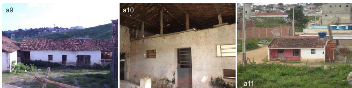
Figura 28 – Acréscimo 1 . a9 – vista da fachada do Acréscimo 1 ; a10 – acesso ao antigo escritório pelo interior da casa de moenda; a11 – vista da nova edificação que abrigou o escritório a partir da década de 1980.
