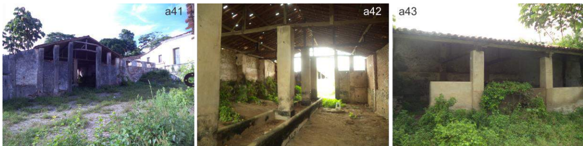
Figura 32 – Casa de bagaço 2. a41 – vista da fachada principal; a42 – vista interna; a43 – vista lateral.
