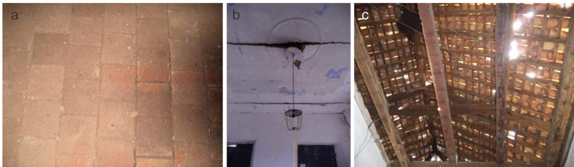
Figura 49 - Piso e forros da Construção Original da casa-grande. a - ladrilhos de barro cozido; b - forro de uma das salas frontais; c - estrutura de sustentação do forro em uma das alcovas. Fonte: Acervo do autor.
