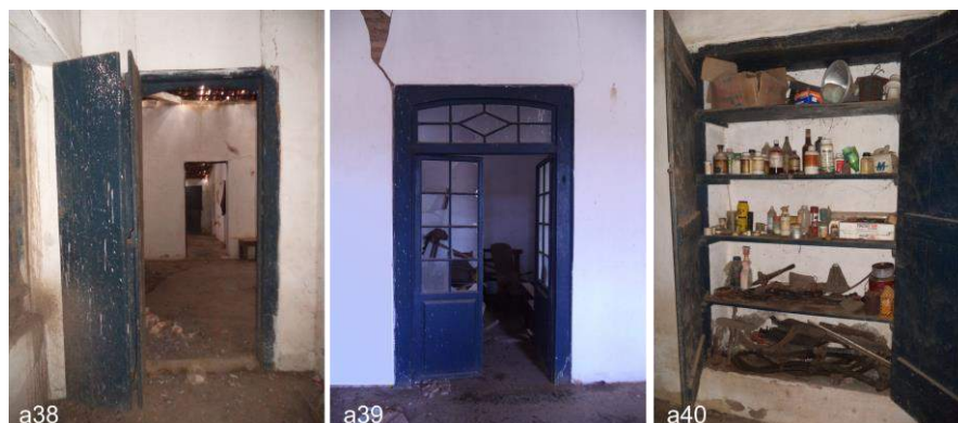
Figura 50 – Esquadrias internas da Construção Original da casa-grande. a38 – porta de um dos corredores, do tipo camarão; a39 – porta de uma das alcovas; a40 – armário embutido. Fonte: Acervo do autor.
