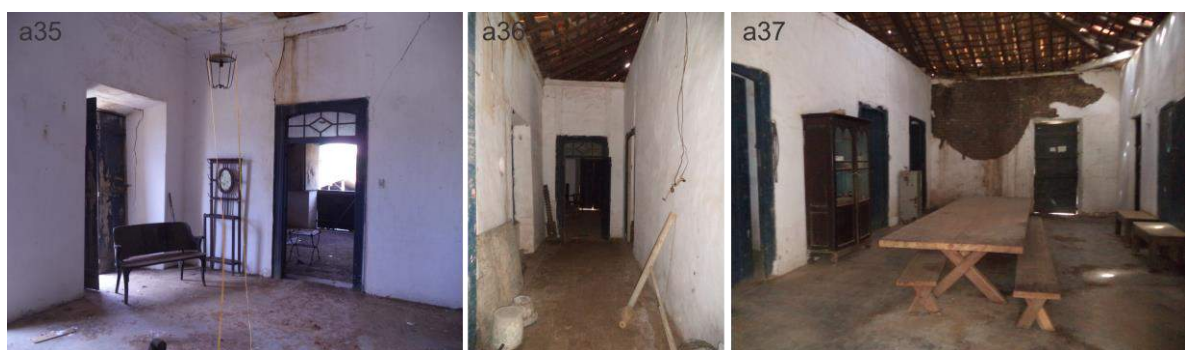
Figura 48 – Construção Original internamente. a35 – vista de uma das salas frontais; a36 – vista de um dos corredores laterais; a37 – vista da sala posterior.
