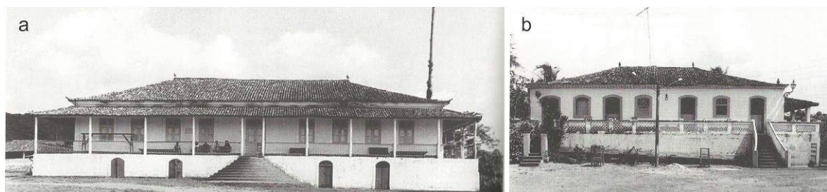
Figura 38 – Casas-grandes dos engenhos Novo da Conceição (a) e São Sebastião (b). Fonte: GOMES, 1998, p. 70.
