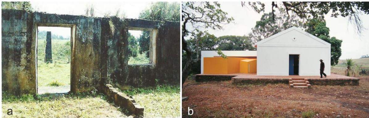
Figura 68 – Casa-grande do Engenho Queira-Deus. a – casa-grande ainda em ruínas; b – casa-grande após o restauro.
