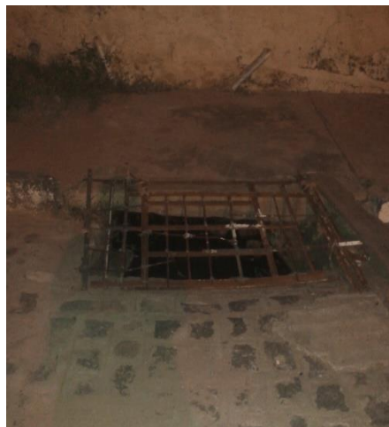
Imagem 36 – Foto de boca de lobo encontrada no Bairro.
