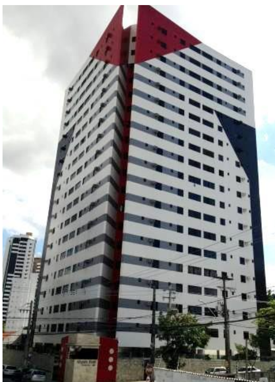
Figura 7 - Edifício Moysés Rizel
