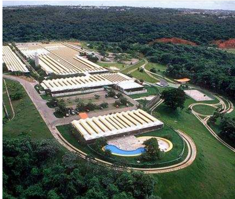
FIGURA 1 - VISTA DE SUPERIOR DO HOSPITAL SARAH KUBITSCHEK. FONTE: WWW.ARCHDAILY.COM.BR
