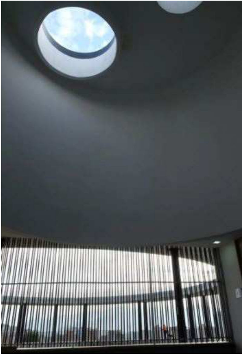
Figura 18: Iluminação zenital da UVA. Fonte: Sergio Gomez, 2018
