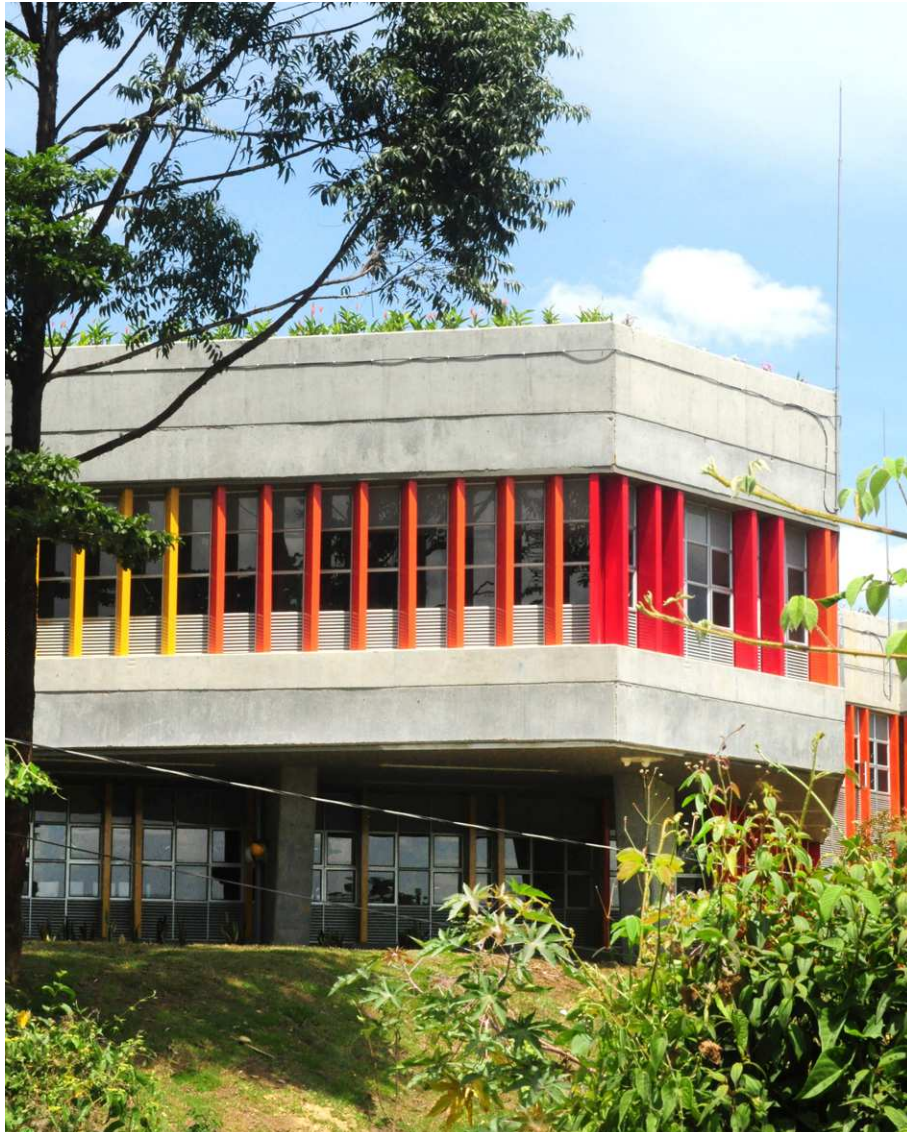
Figura 33. Brises para proteção solar Fonte: Archdaily, 2016
