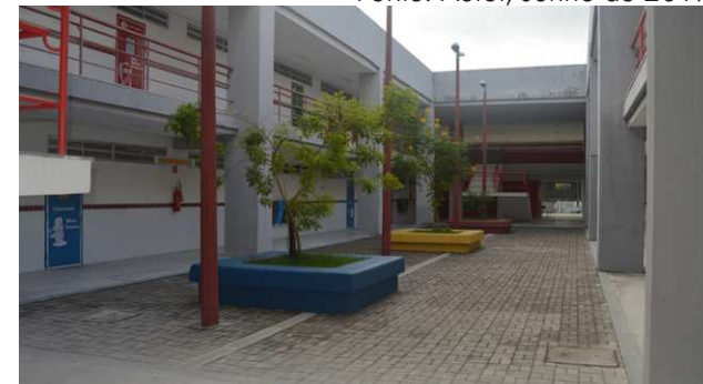
Figura 44: Bloco com salas de aulas e laboratórios Fonte: Autor, Junho de 2017
