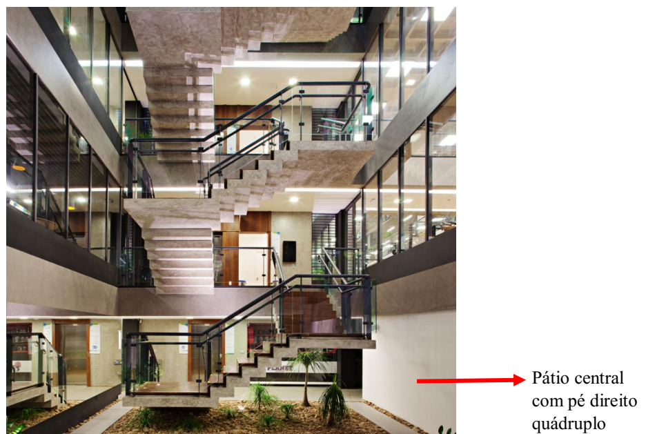
Figura 12 – Circulação vertical e passarela
