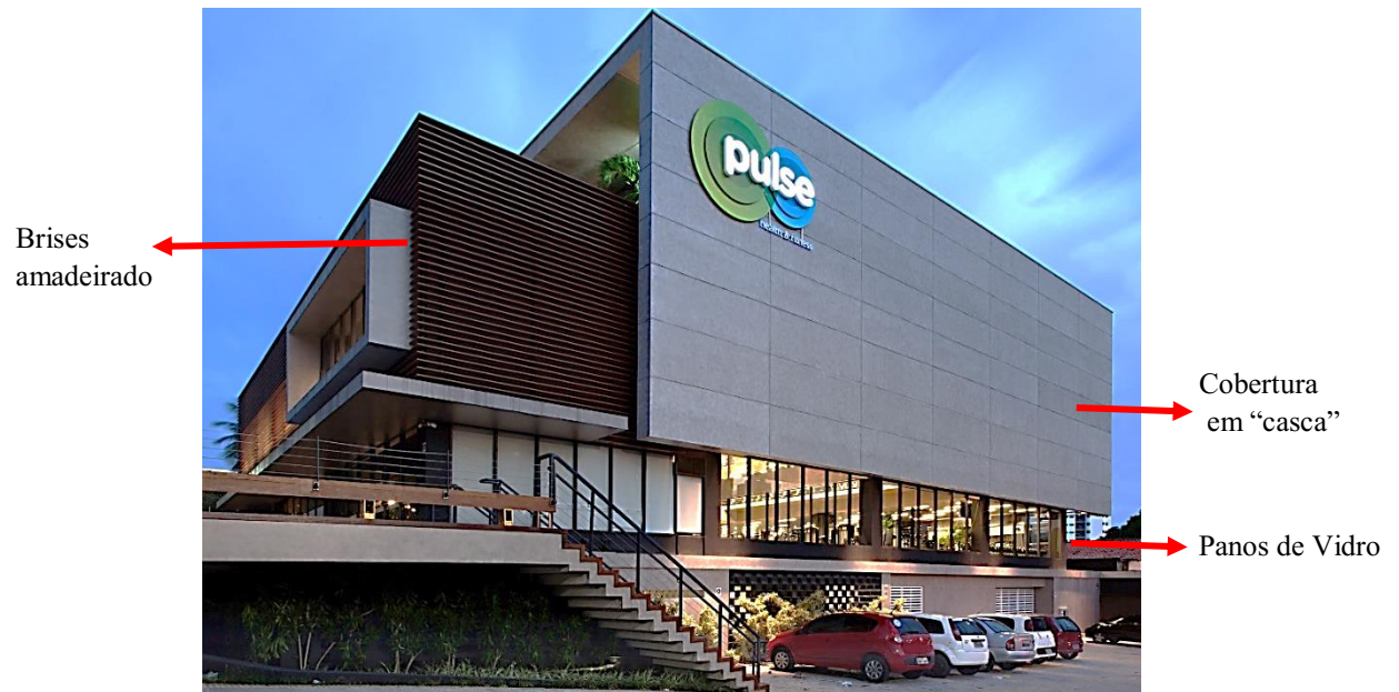
Figura 04 – Vista lateral da edificação
