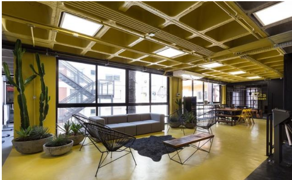
Figura 24 – Laje nervurada aparente e área de estar e recepção em amarelo.
