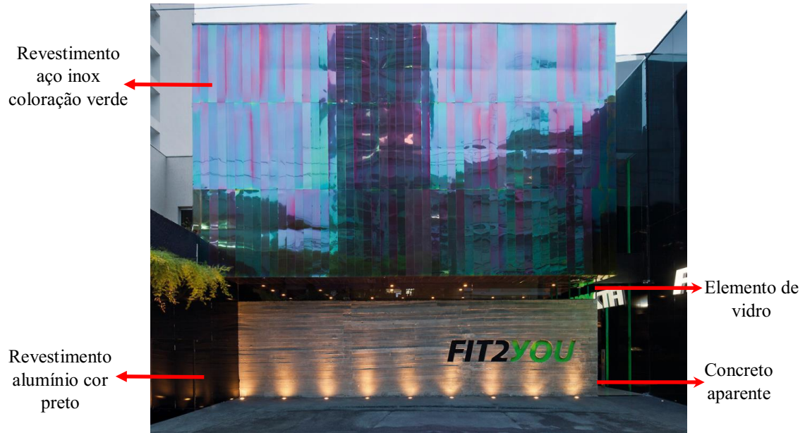
Figura 36 – Materiais utilizados na fachada
