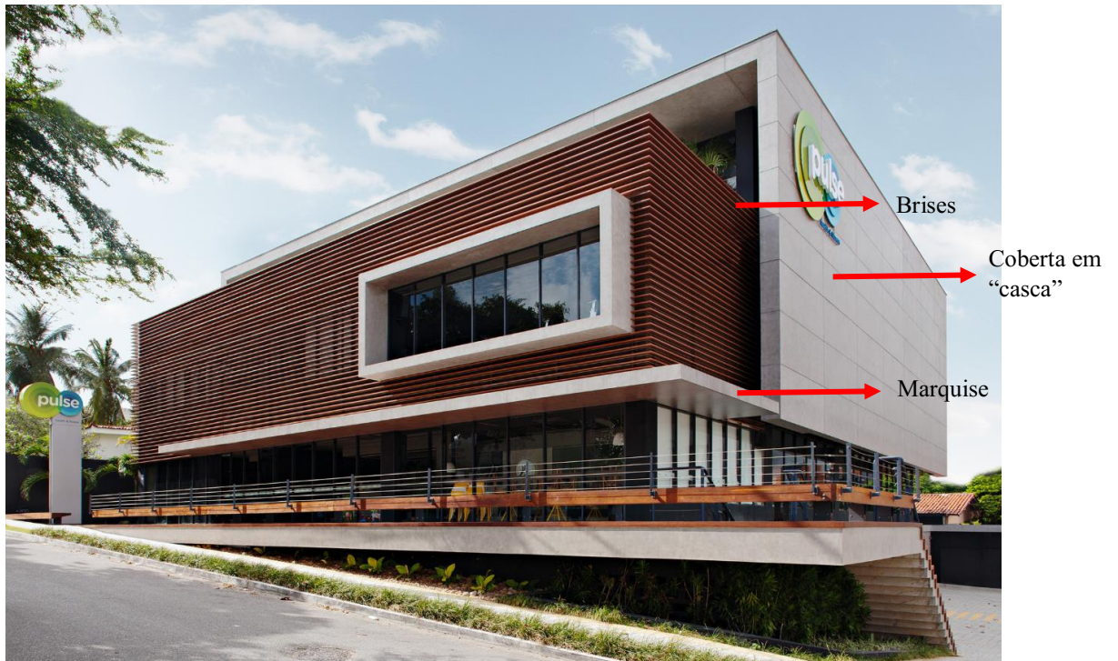
Figura 11 – Edificação – Fachadas norte e oeste
