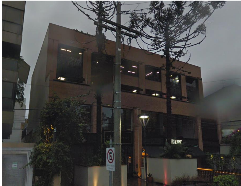
Figura 19 – Fachada da edificação onde se localiza o Estúdio
