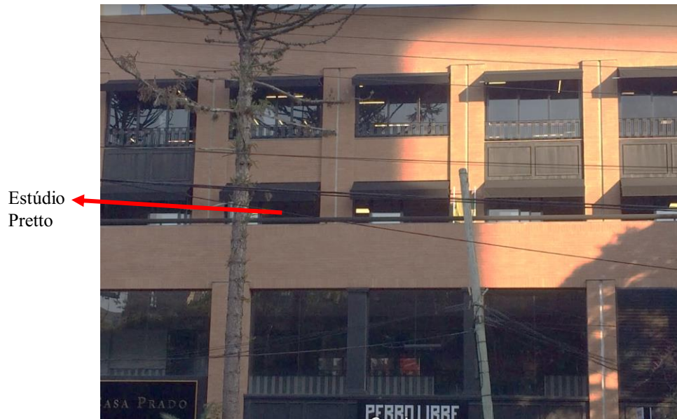
Figura 22 – Fachada da edificação
