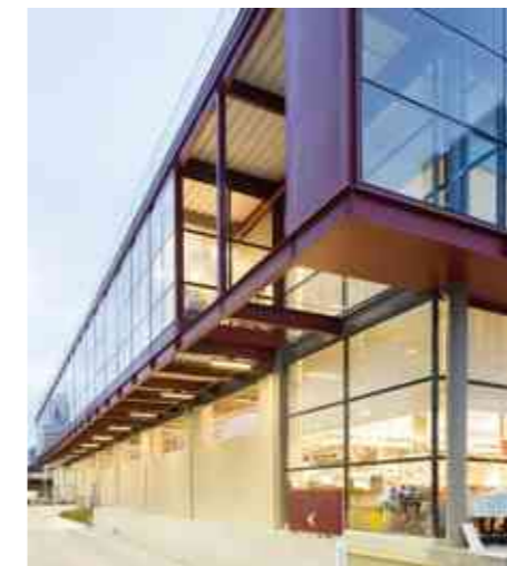
Figura 22: Fachada do Eataly Brasil Fonte: www.galeriadaarquitectura.com.br , 2017.
